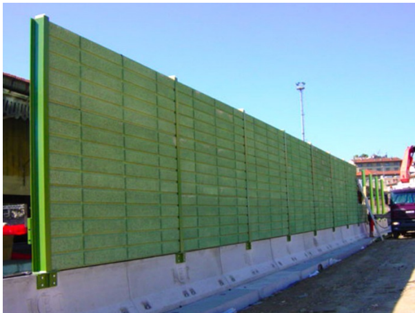
Barriera acustica provvisoria di cantiere per la protezione dei ricettori più prossimi alle aree di lavorazione
