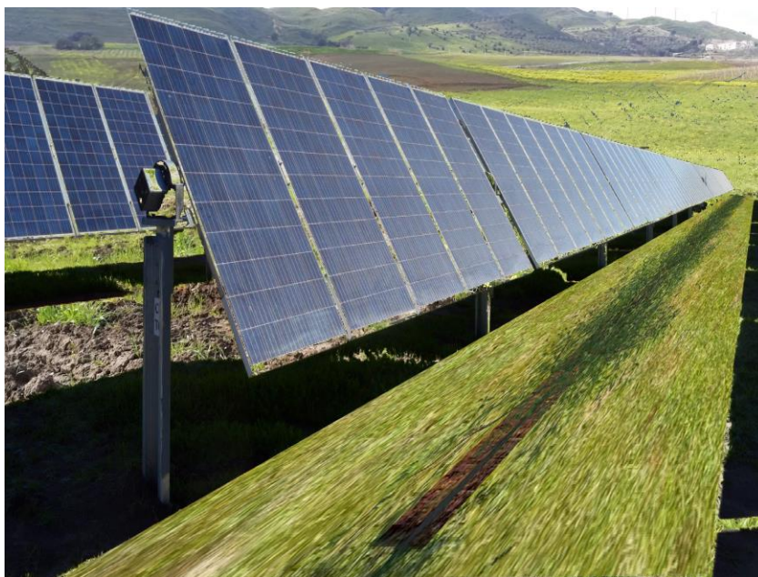
Figura 4-2 Punto di osservazione PV5- da strada interpoderale est verso ovest post operam
