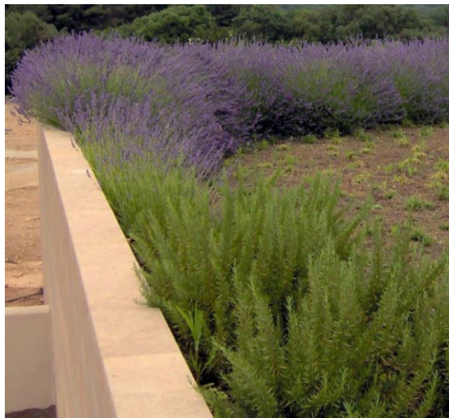
Fig. 9.7 - Esempio di copertura a Verde con piante aromatiche
