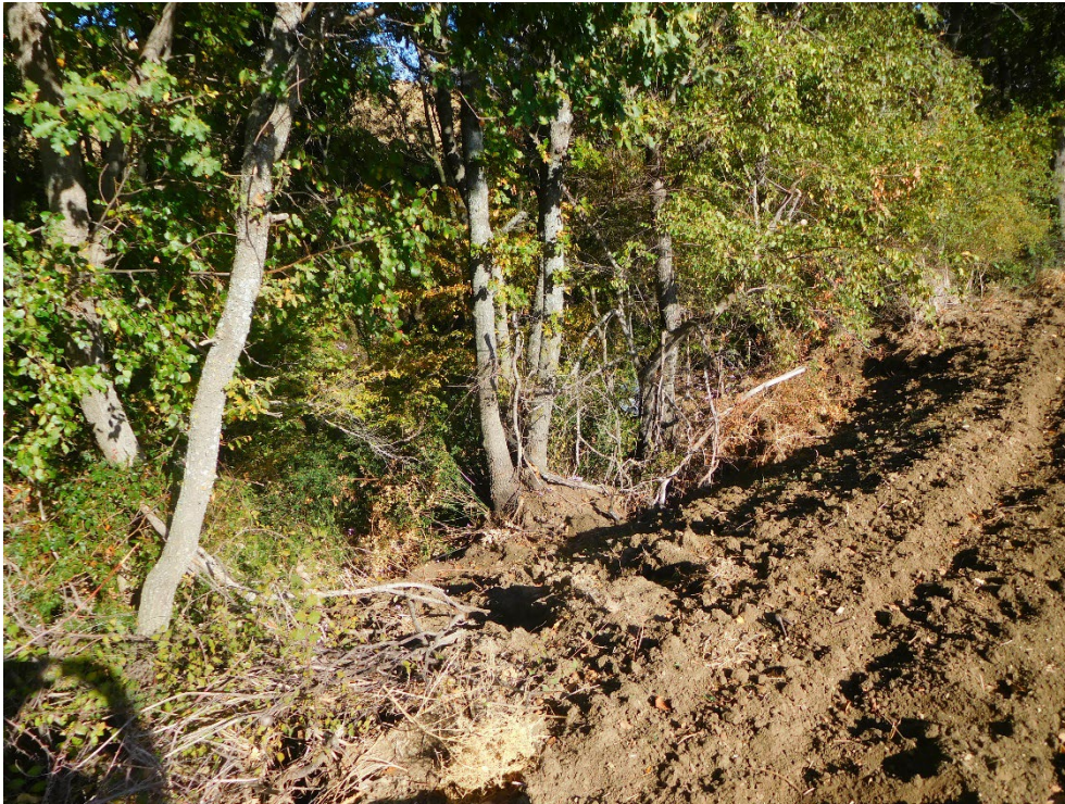
Figura 1-31. Tratto in erosione
