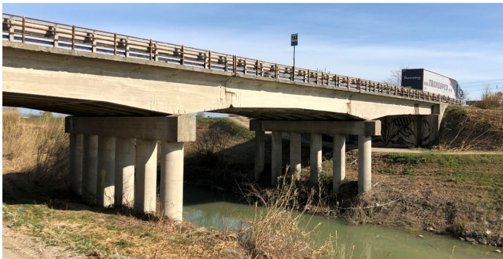
Figura 15: Vista del ponte sul fiume Montone
