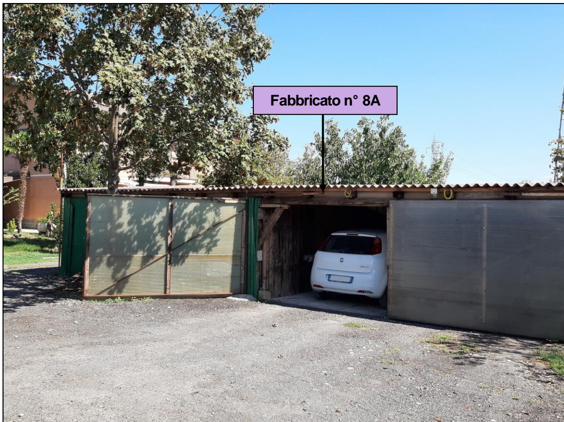
Figura 5 – Fabbricato n° 8A utilizzato come autorimessa, punto di osservazione N.2
