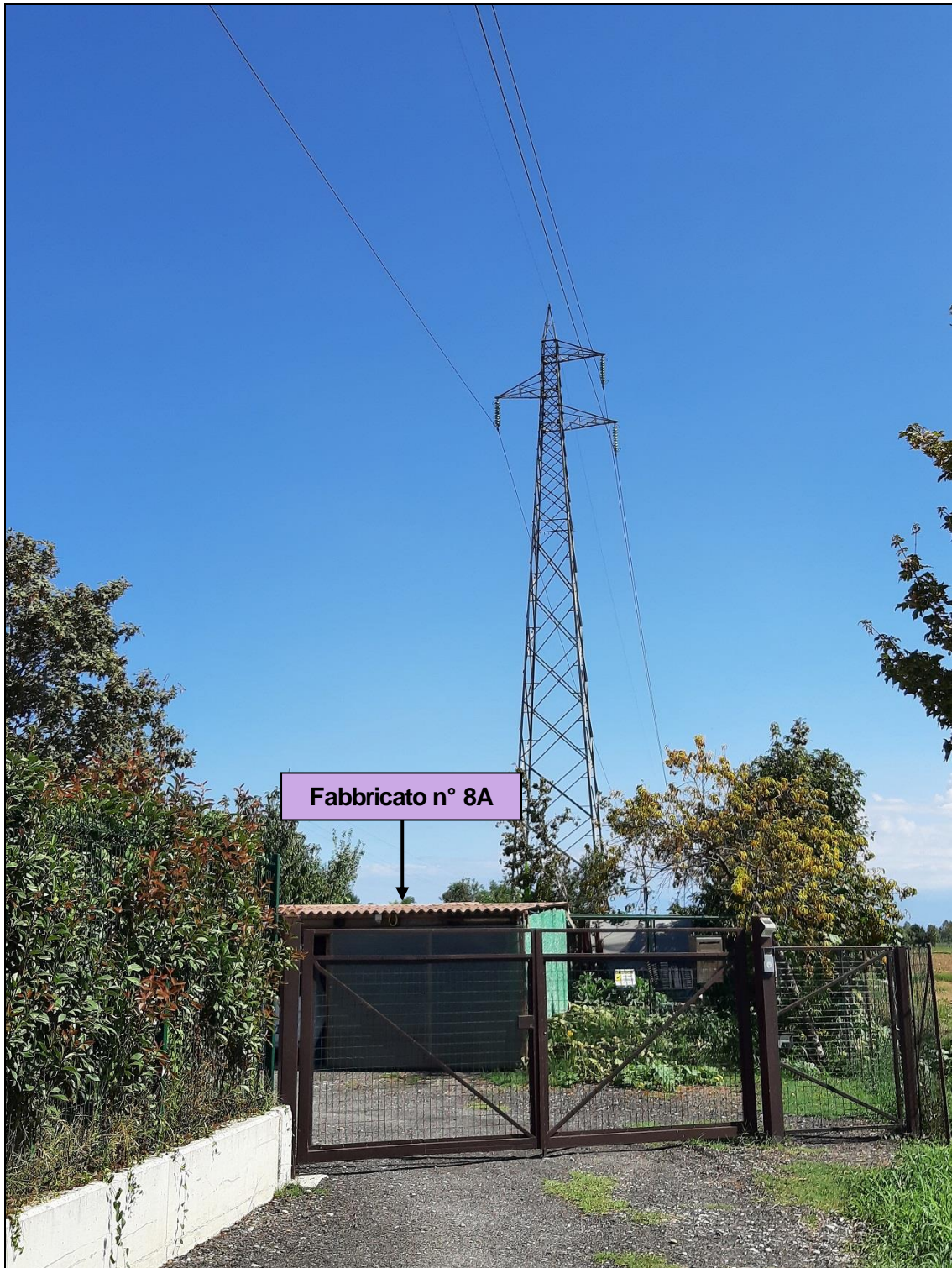
Figura 4 – Fabbricato n°8A e sostegno della linea 132 kV 23771A1 “Mozzanica – Romano di Lombardia”, punto di osservazione
