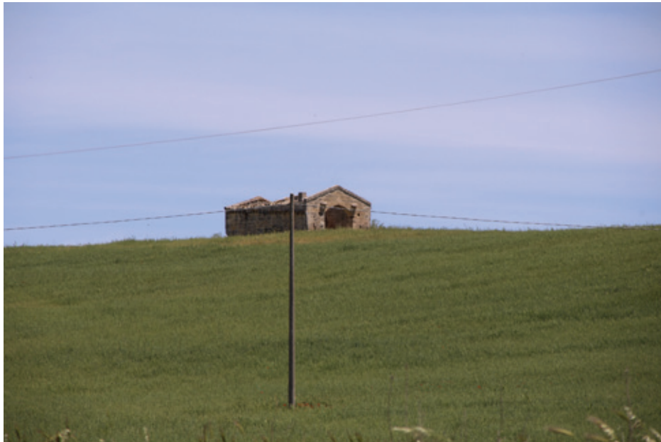
IMG_6653_Mass_IESCE_ edificio in abbandono a NE di masseria IESCE.JPG
