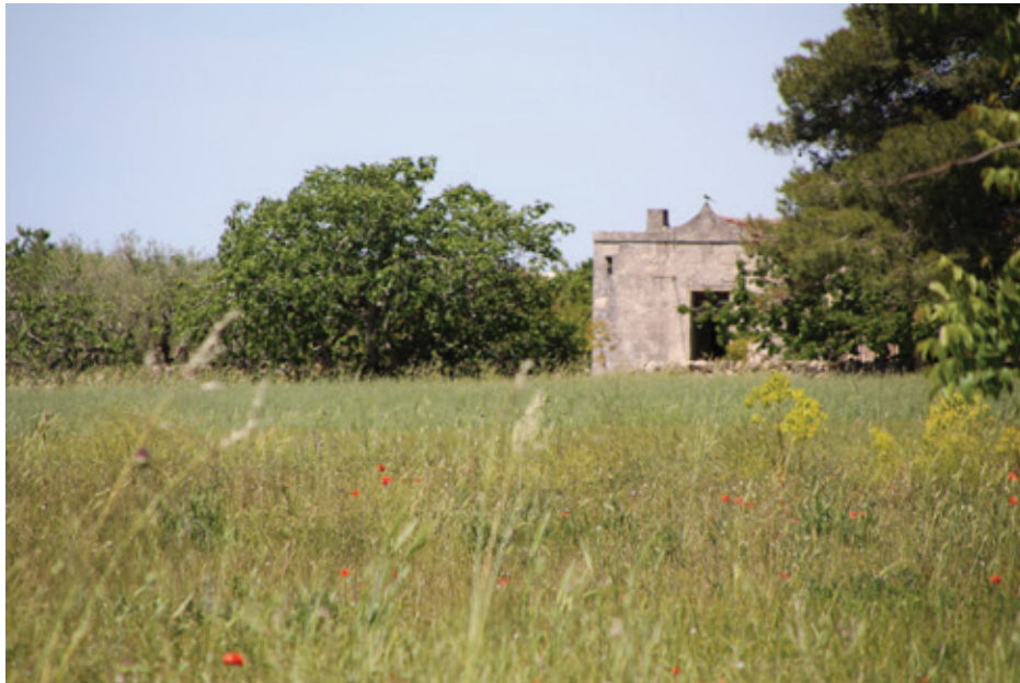
IMG_6606_Mass_IESCE_AREA 3_da NE.JPG
