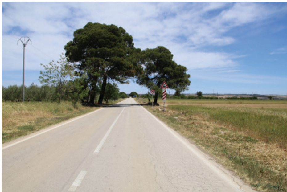
IMG_6660_Mass_IESCE_SP 160_verso AREA 5_6_7.JPG
