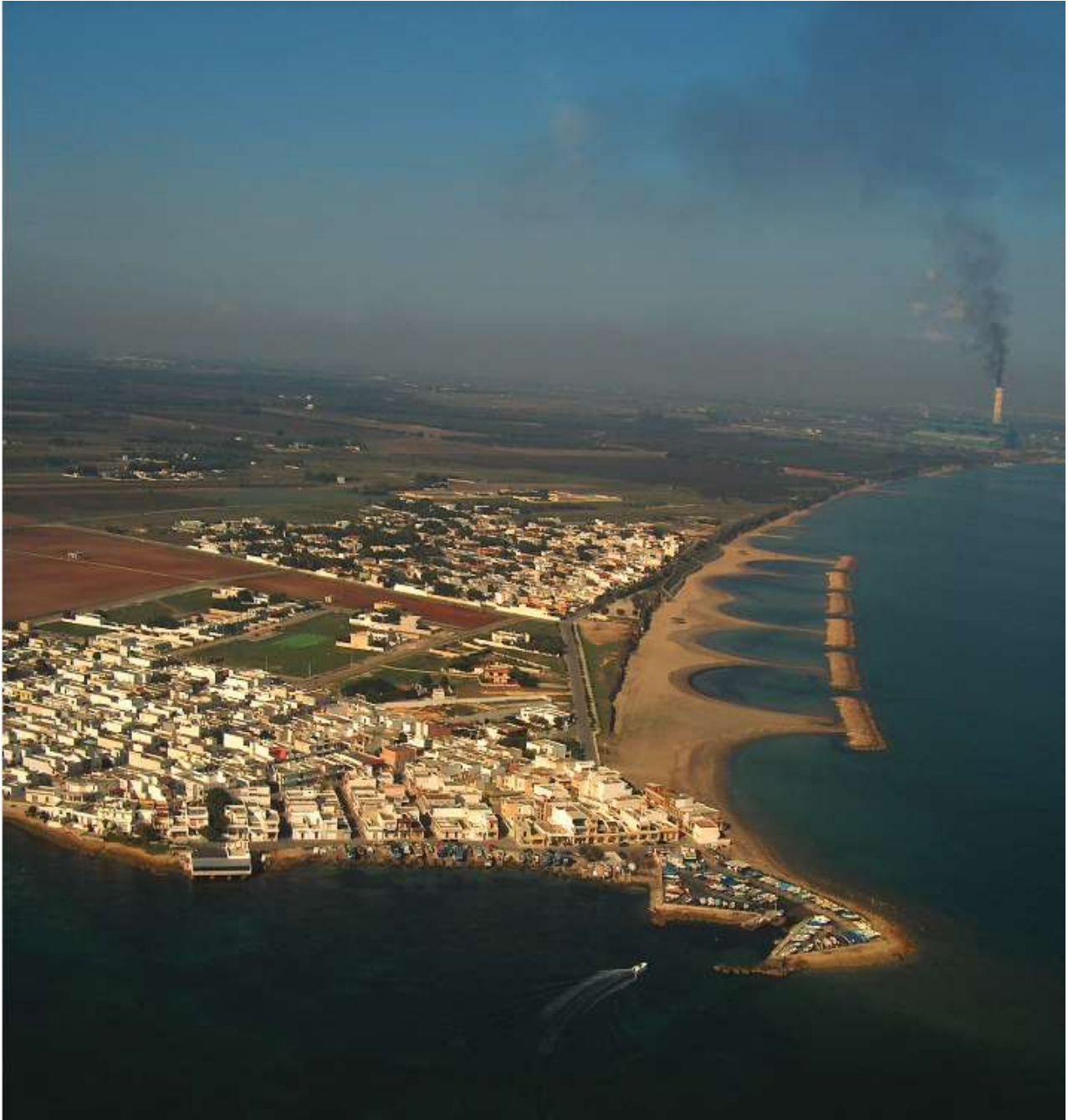
La Centrale Termoelettrica "Federico II" vista da sud dalla località "Campo di Mare"
