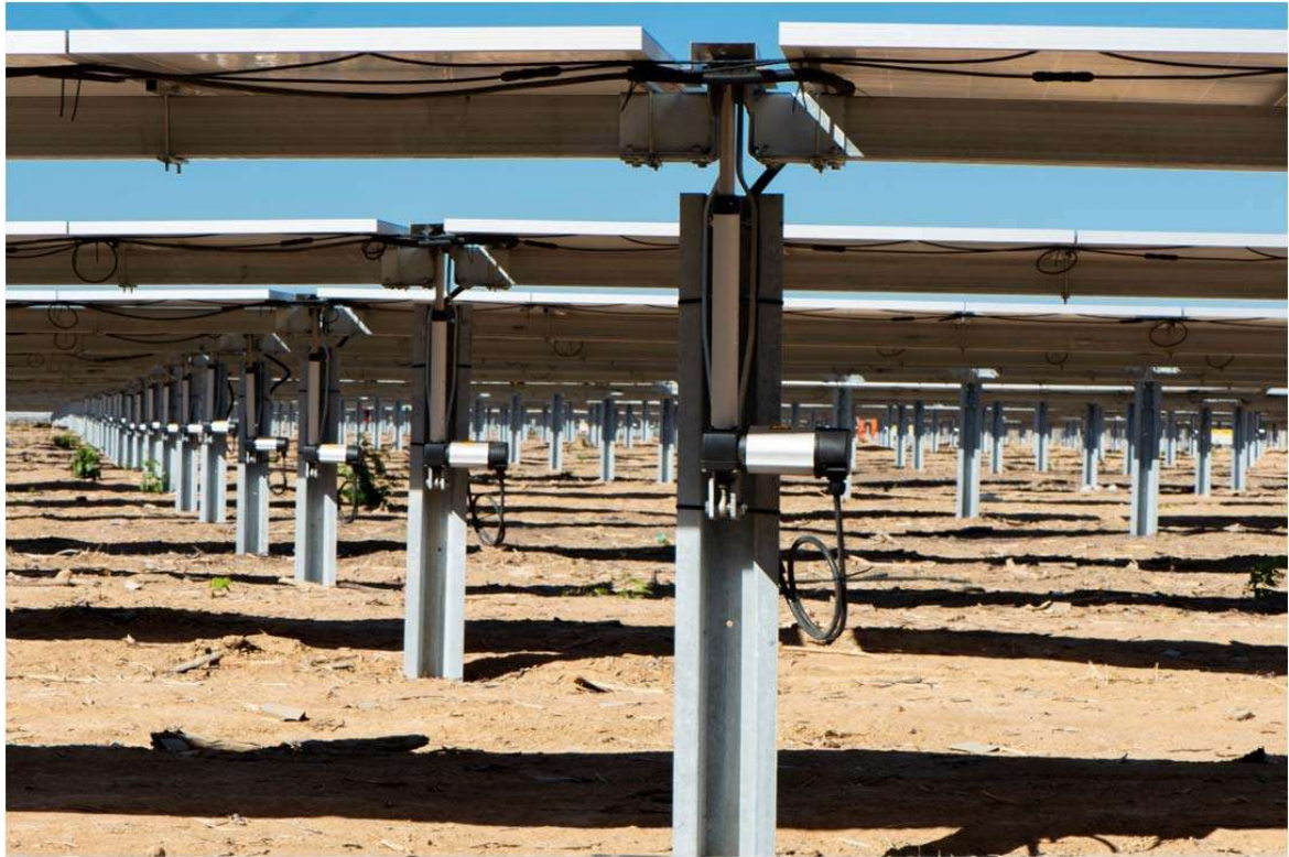
Esempio di sostegni dei tracker infissi nel terreno
