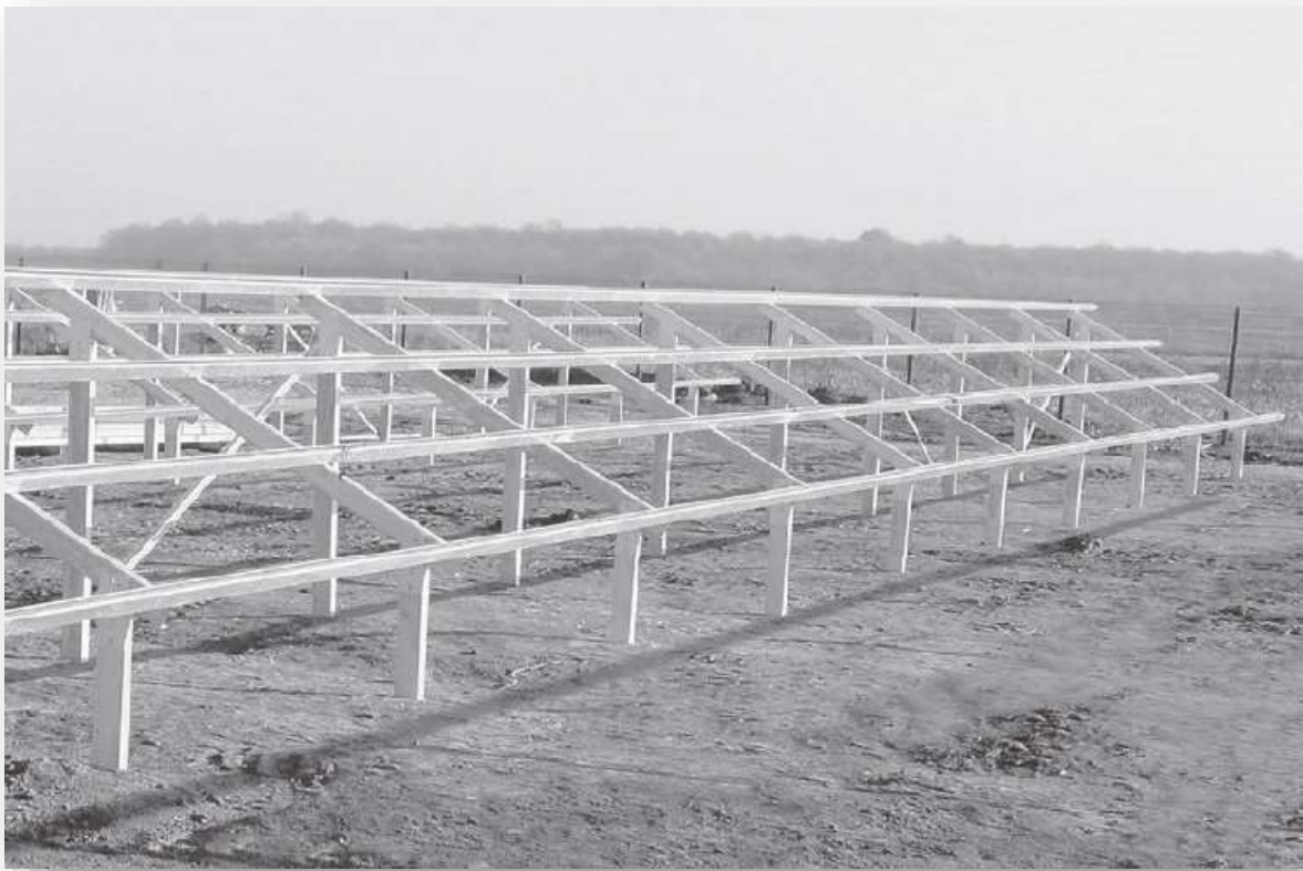
Figura 2 - Esempio struttura fissa
