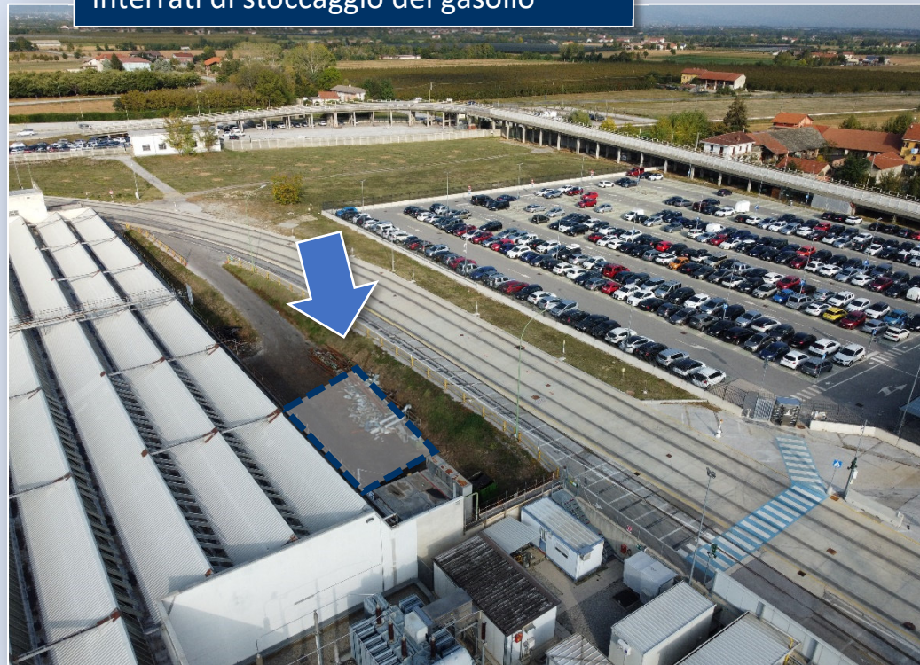
Area dello Stabilimento Michelin ove è prevista l'installazione dei serbatoi interrati di stoccaggio del gasolio
