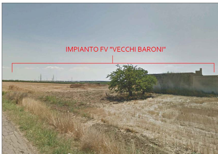
Figura 23: Vista prospettica dell'impianto da Masseria Vecchi Baroni
