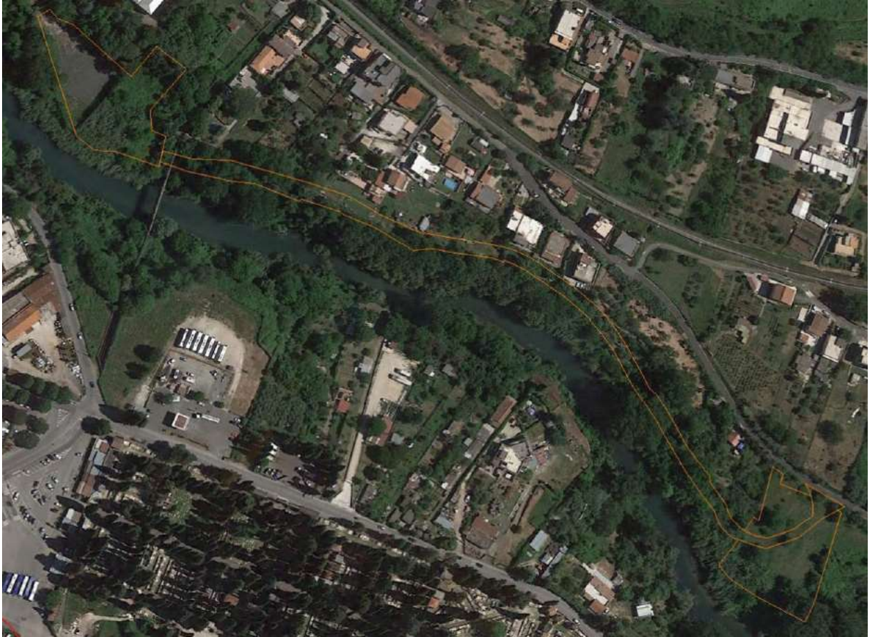
Figura 6-6 Area Pozzo PZ3
