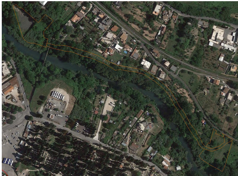
Figura 9. Inquadramento territoriale area cantiere n.3 e relativa strada di accesso
