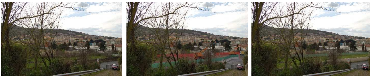
Figura 2 Sequenza temporale delle potenziali alterazioni delle condizioni percettive : ante – corso d’opera – post operam
