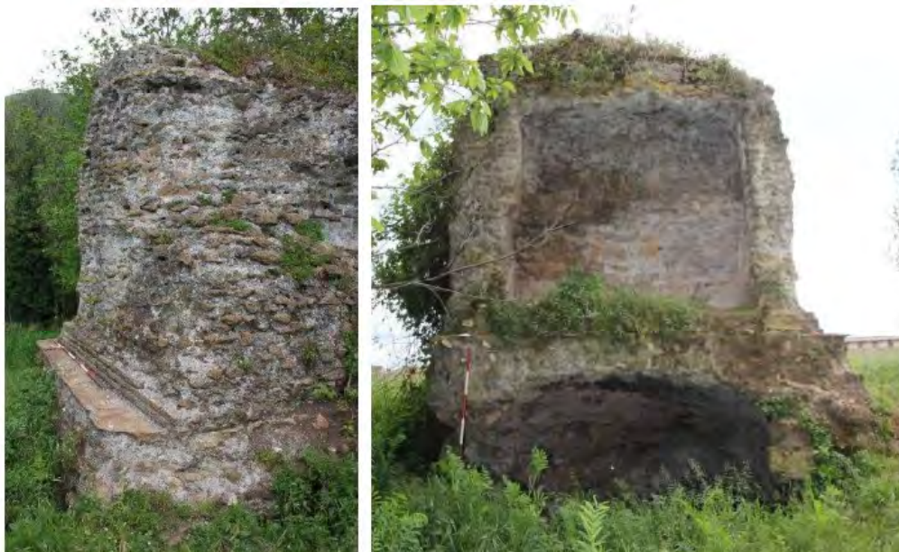
FIGURA 30 - Colle Santo Stefano. Resti di una struttura in conglomerato cementizio e scapoli di tufo ( Sito 26 ) da PIZZICONI-PELLEGRINI 2016
