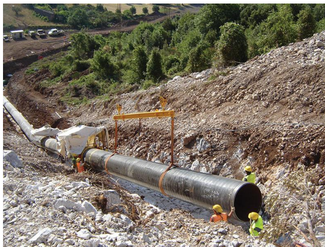
Figura 7. Messa in opera di condotte con teleferica
