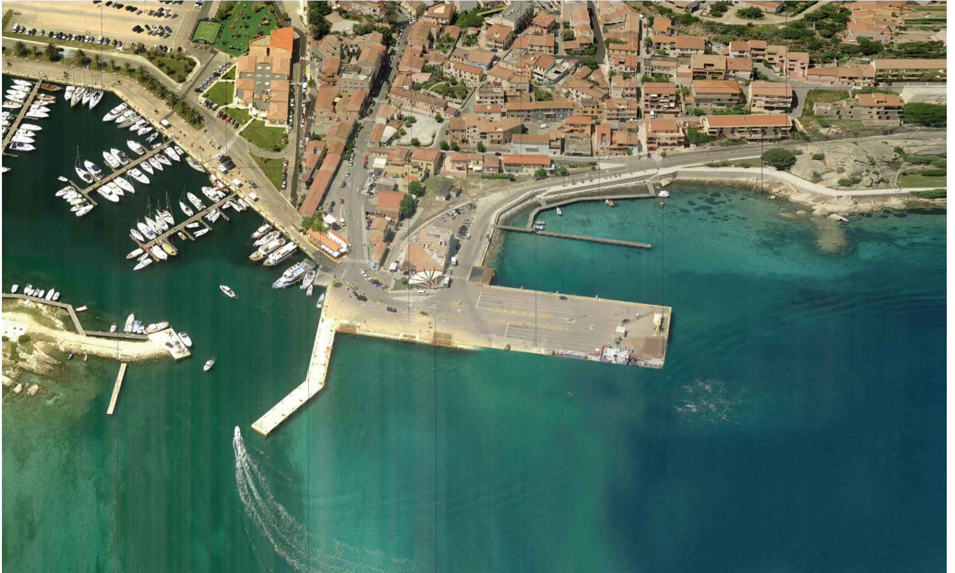
STATO DI FATTO 01 – Vista generale da Est
