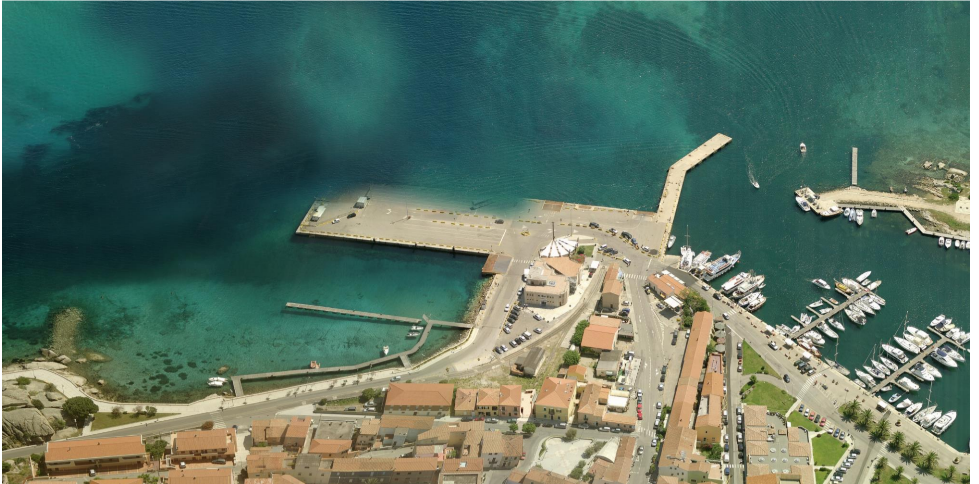
STATO DI FATTO 02 – Vista generale da Ovest
