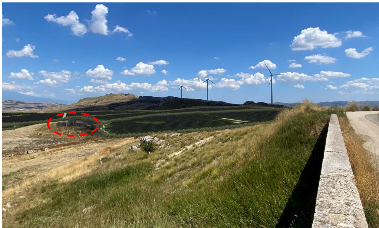
FIGURA 5 - FOTOSIMULAZIONE 8 DAL TRATTO PANORAMICO SP162 VERSO IL BENE ISOLATO CASE CEPPONE (EVIDENZIATA IN ROSSO)
