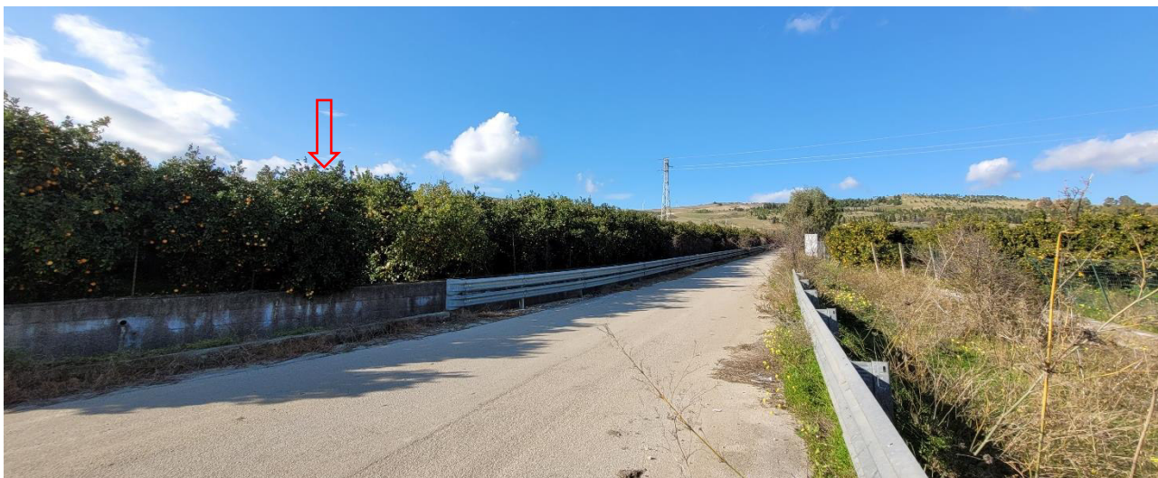
Figura 18: Vista dal punto n. 7 _ Strada SP162 verso l'area di progetto
