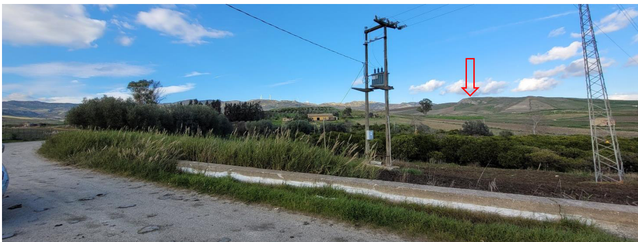
Figura 22: Vista dal punto n. 9 _ Strada SP109 verso l'area di progetto
