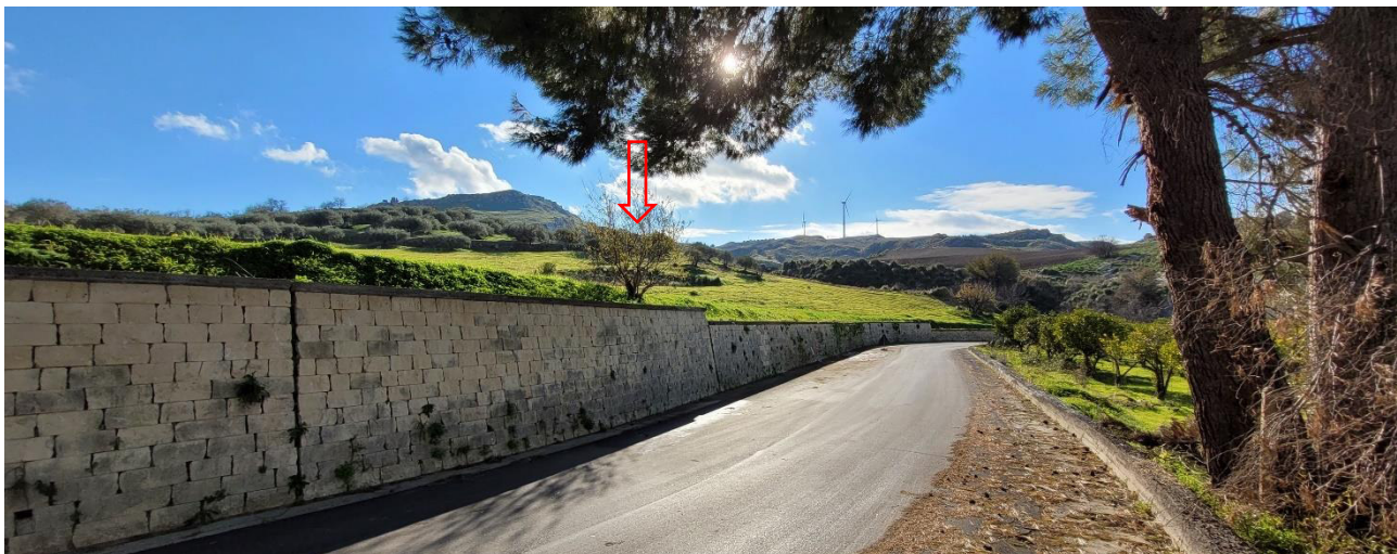
Figura 16: Vista dal punto n. 6 _ Strada SP108 verso l'area di progetto
