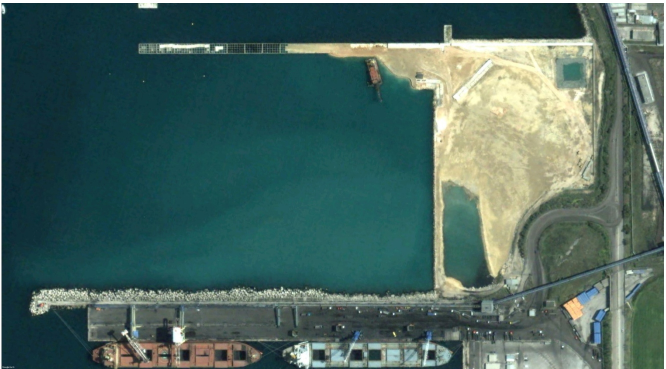
Figura 2 - Avanzamento opere al maggio 2003.
