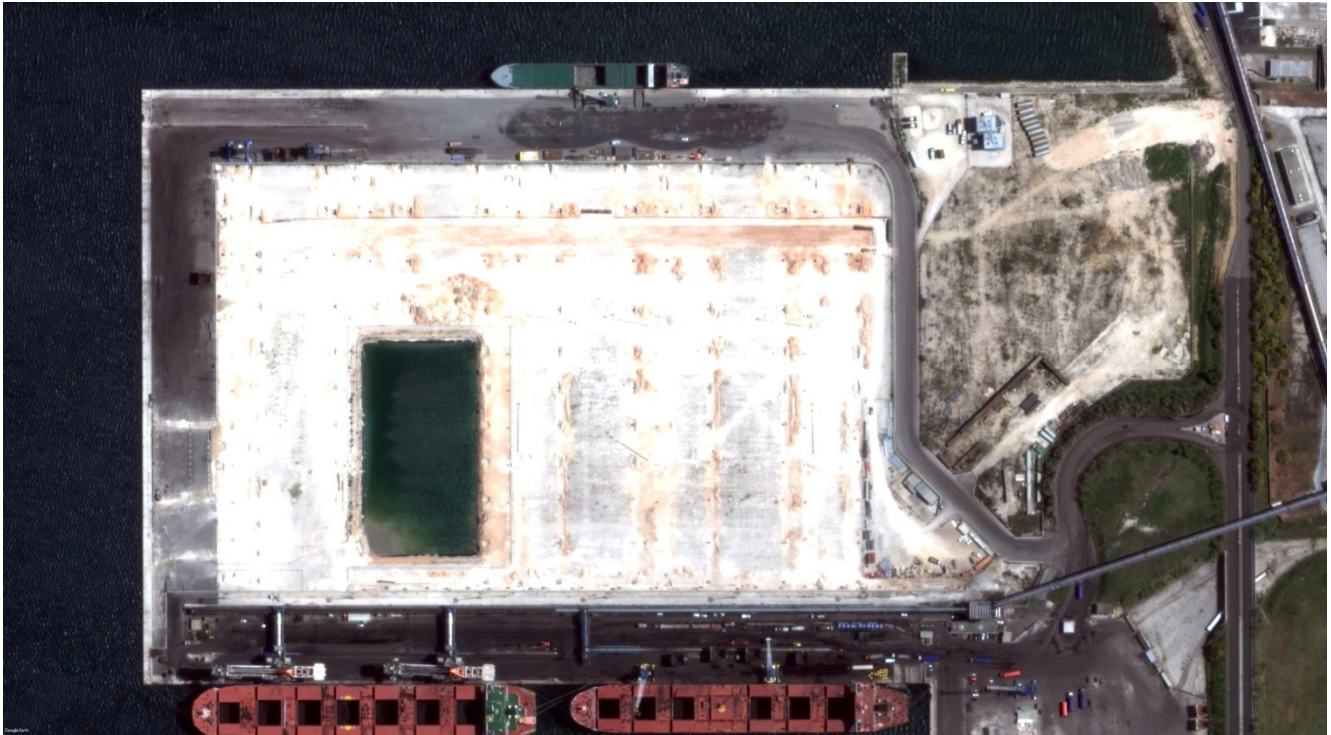
Figura 4 - Molo di Costa Morena est con vasca di colmata in cui sono stati refluiti i sedimenti escavati.
