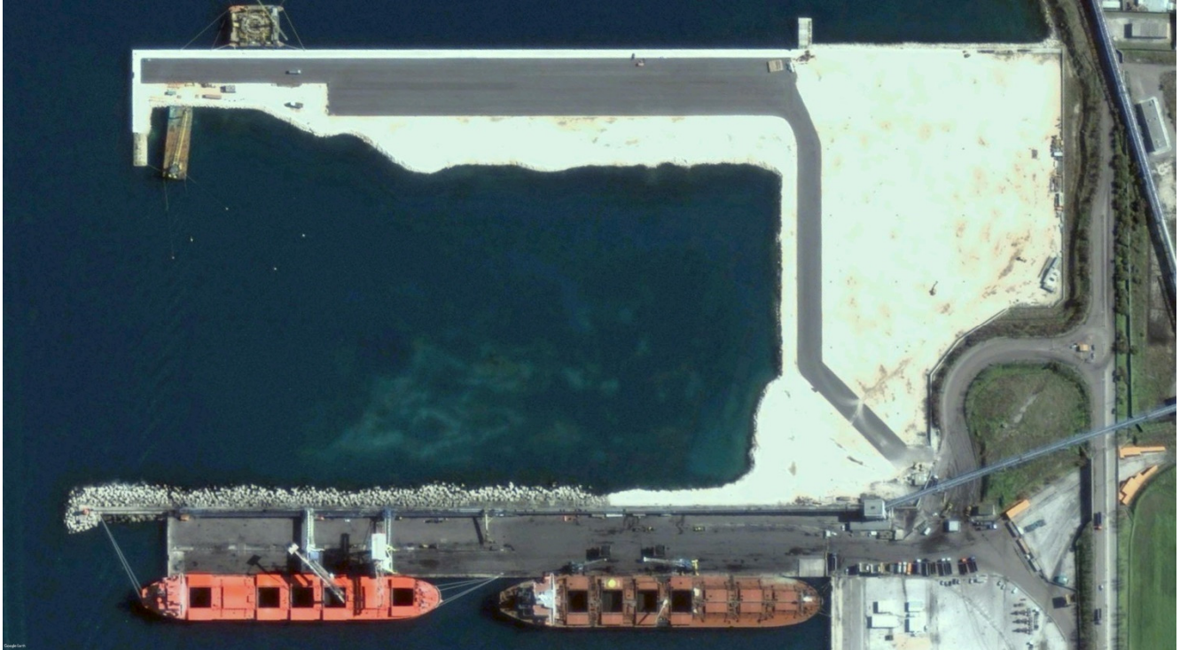
Figura 3 - Avanzamento opere al marzo 2005.
