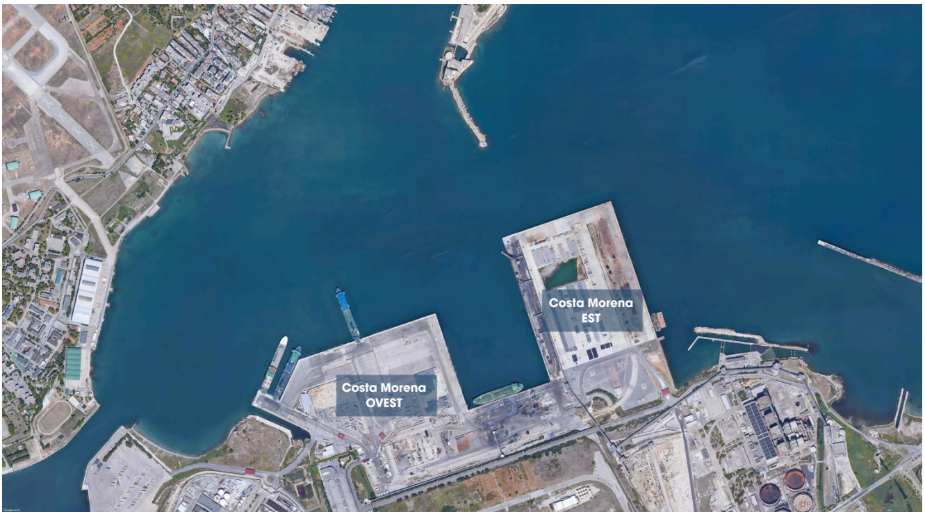
Figura 1 - Porto di Brindisi. Aree portuali di cui riferisce la nota con riguardo ai lavori di dragaggio.
