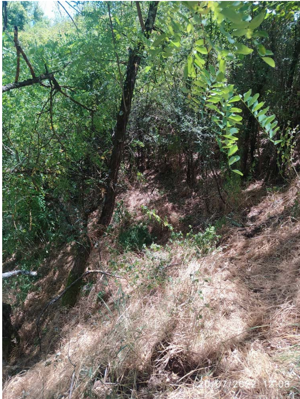
Figura 28 - Orlo di scarpata attivo con frattura di trazione retrostante che isola un elemento destinato a franare comportando l'arretramento del ciglio. Il processo si ripete stagionalmente con continuo arretramento del ciglio di scarpata.
