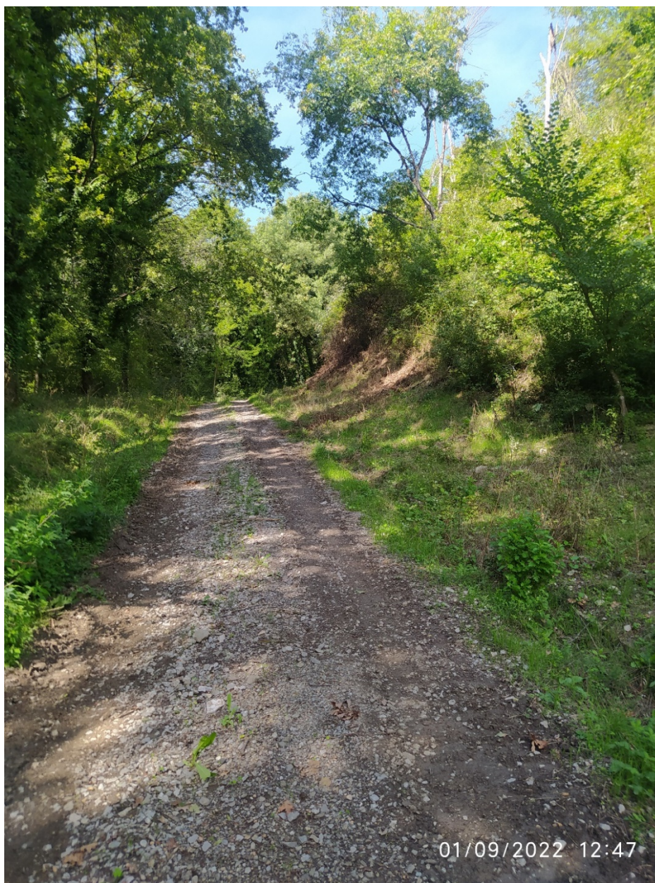
Figura 26 – Viabilità esistente, corrispondente al tracciato della strada di progetto. Si noti la vicinanza della scarpata di destra rispetto alla sede stradale che dovrà essere protetta, pertanto, dalla possibile invasione di materiale trasportato.
