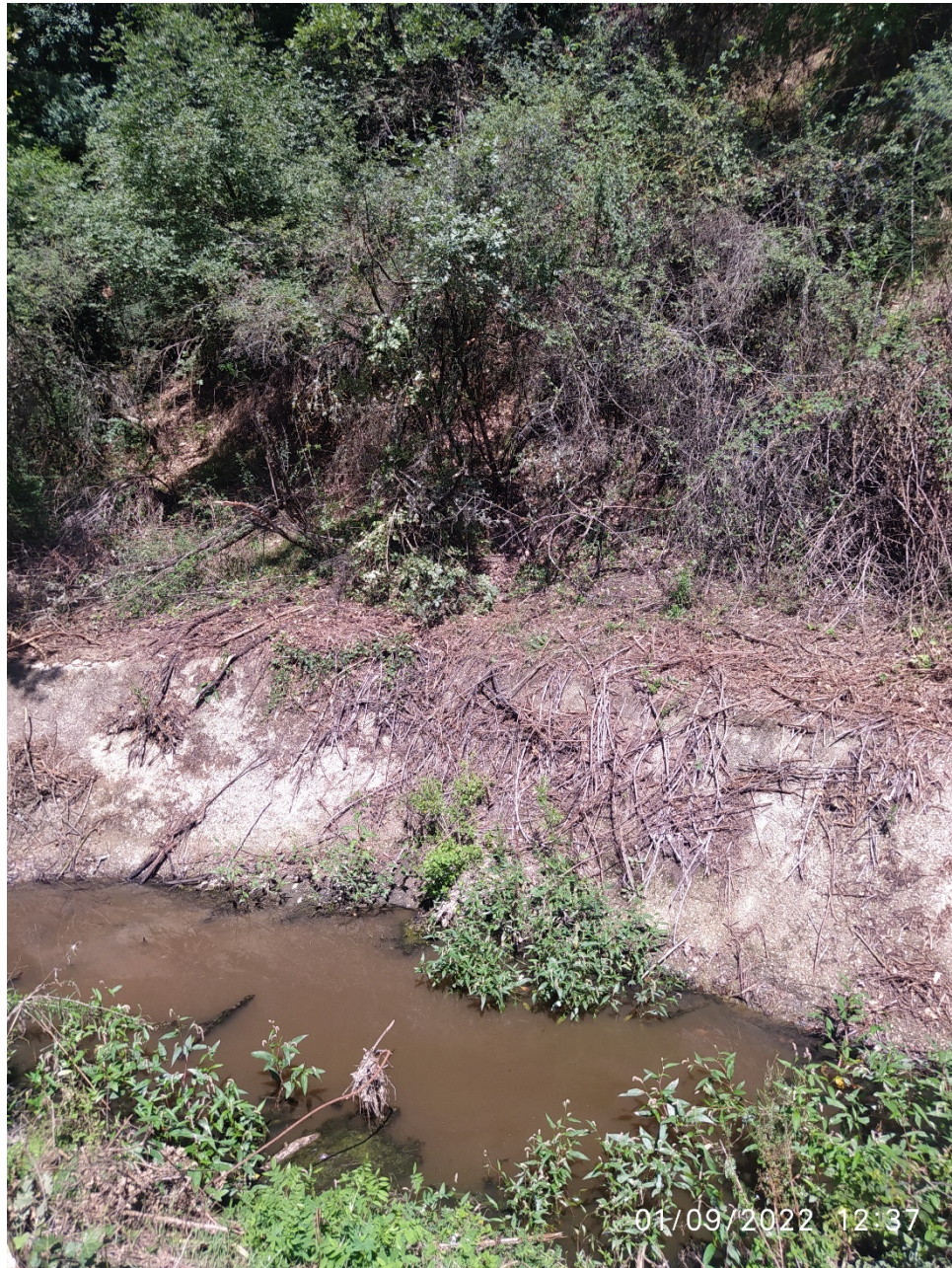
Figura 23 – Ristagno di acqua dovuto all'interrimento della canaletta a valle.
