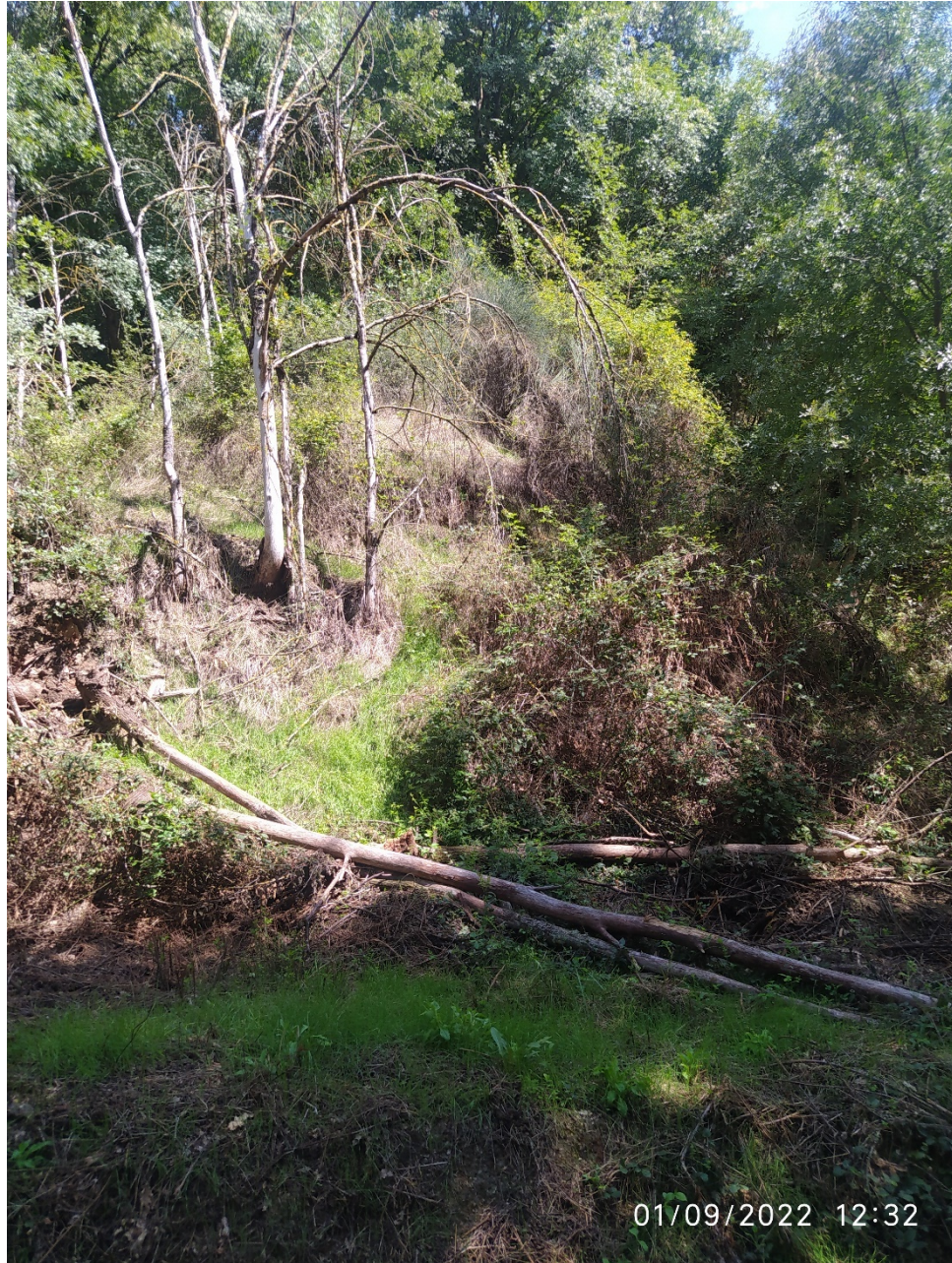
Figura 21 – Fenomeni di erosione e frane localizzate nell'area B in un tratto a forte pendenza.
