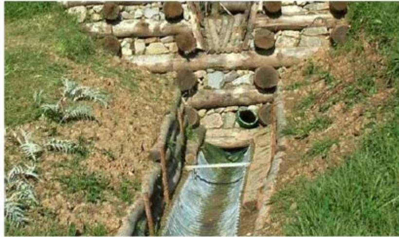
Figura 47 - Canalette prefabbricate in lamiera.
