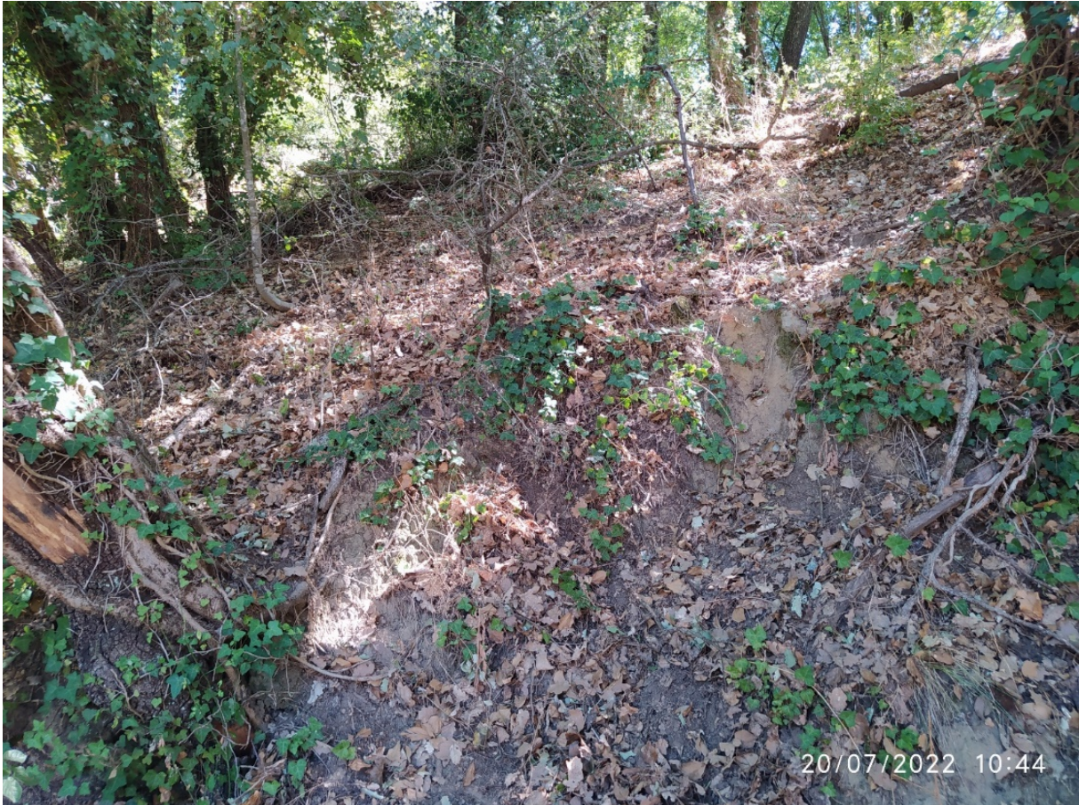
Figura 16 - Fenomeni erosivi con piccole frane superficiali e scalzamento degli apparati radicali che interessano i terreni naturali (Sabbie di Borro Cave) ai margini della discarica di Vinesimo.
