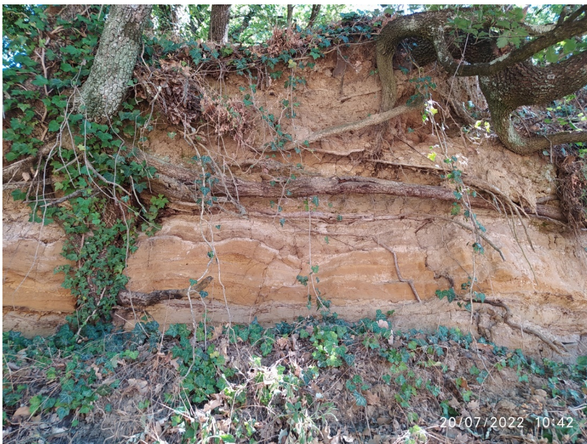
Figura 15 - Affioramento di Sabbie di Borro Cave messo a nudo dall'erosione accelerata del suolo per processi di franosità diffusa, area nord della discarica di Vinesimo.
