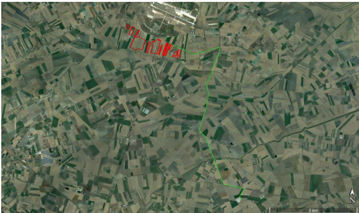
Figura 4.2: Area di progetto (rosso) e percorso di connessione (verde) alla cabina di trasformazione.
