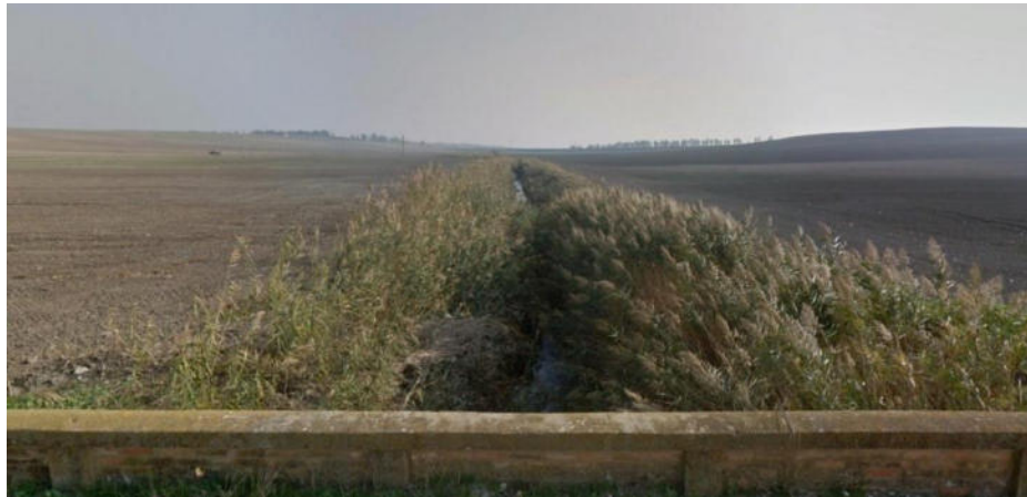
Figura 3.10: Canale Farano in corrispondenza dell'attraversamento sulla strada Contrada Lamandola, nei pressi dell'area di progetto, vista verso valle.
