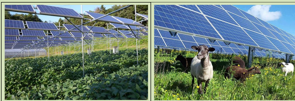
Figura 1.1: Esempi Impianti Agri-voltaici
