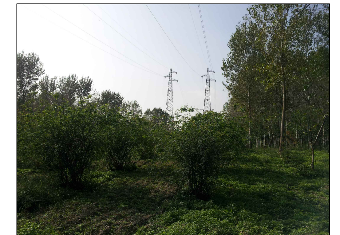
Esempio di impianto arbustivo sotto elettrodotto
