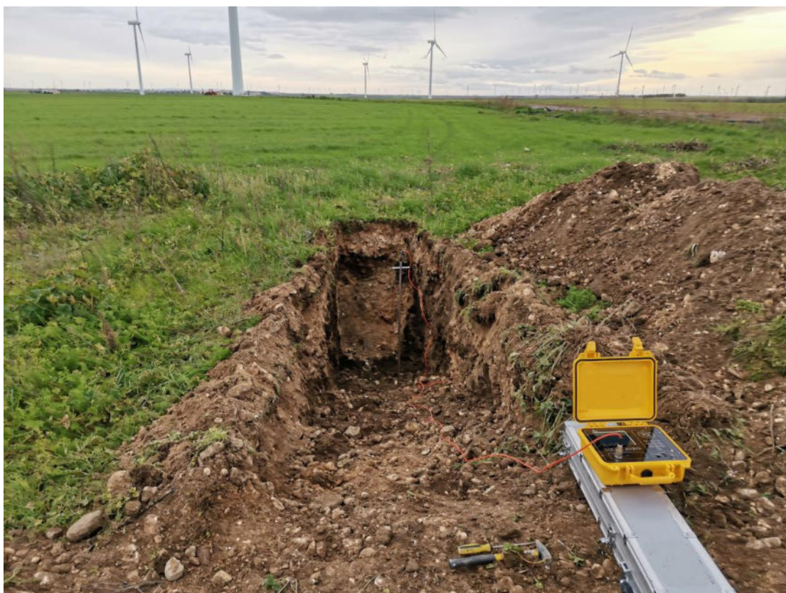
FOTO 2 – MISURE DI RESISTIVITÀ TERMICA TRINCEA 2
