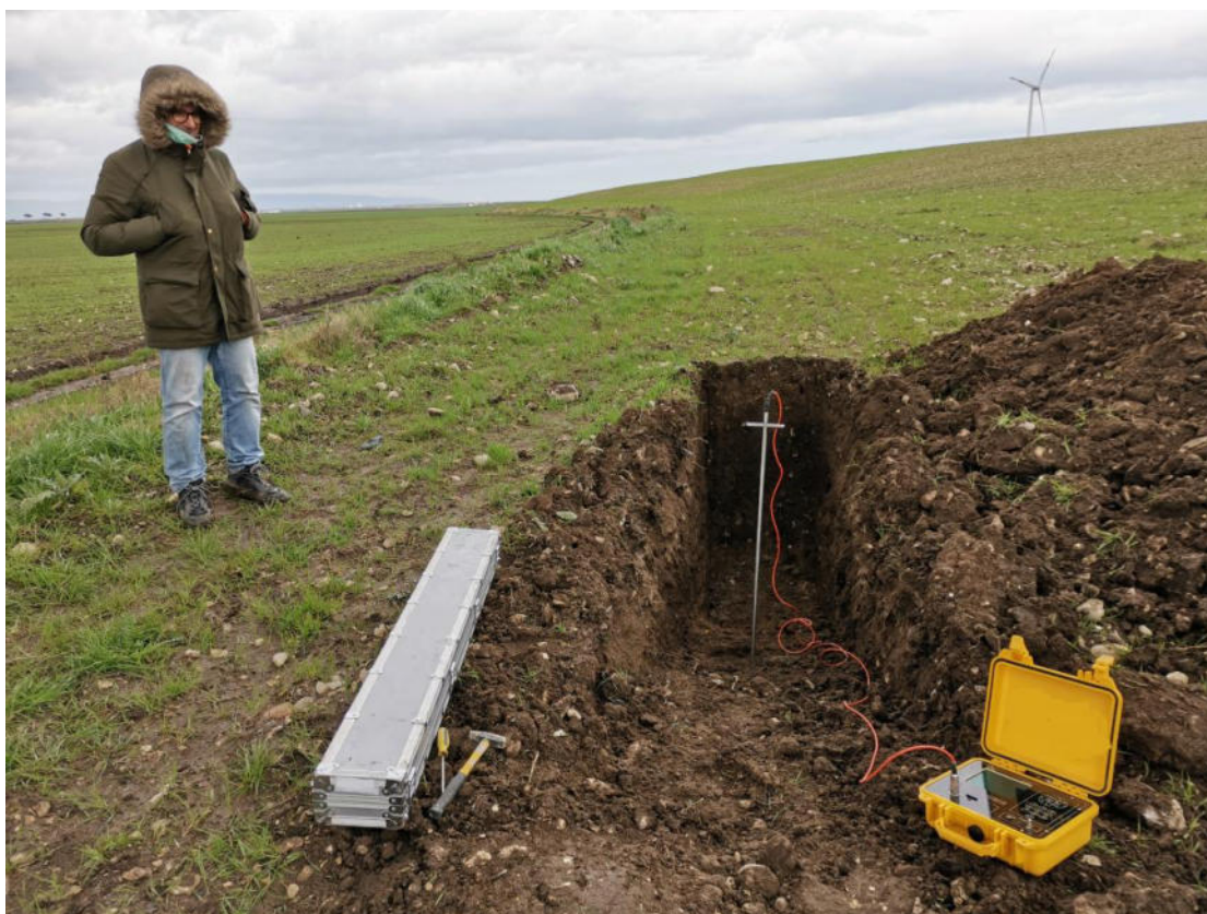
FOTO 4 – MISURE DI RESISTIVITÀ TERMICA TRINCEA 4
