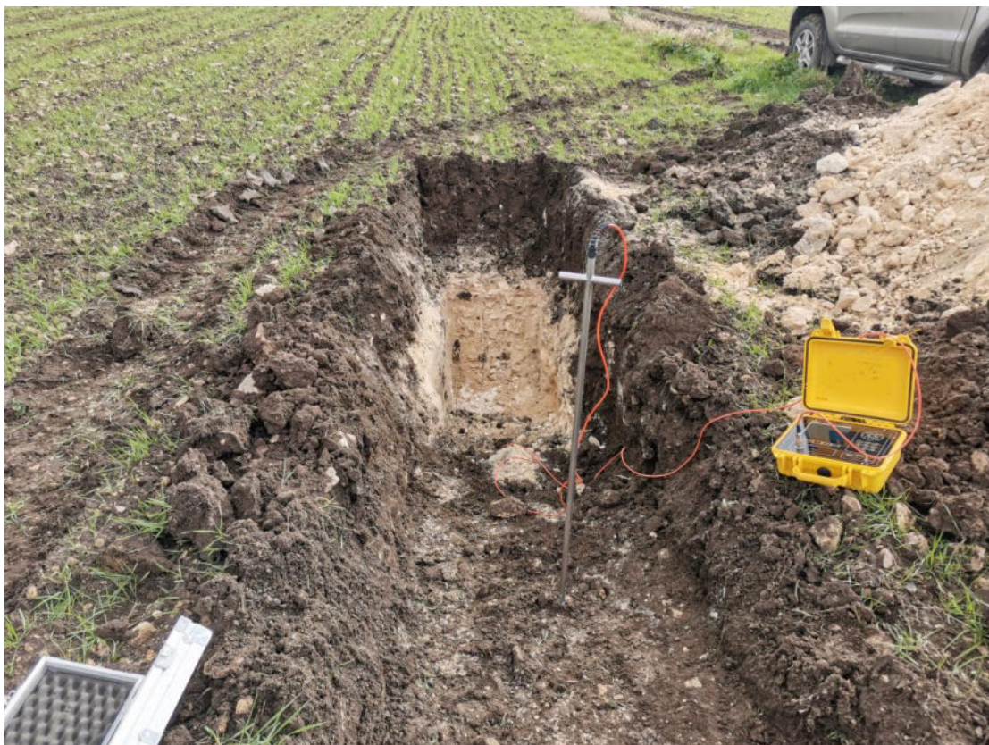
FOTO 5 – MISURE DI RESISTIVITÀ TERMICA TRINCEA 5
