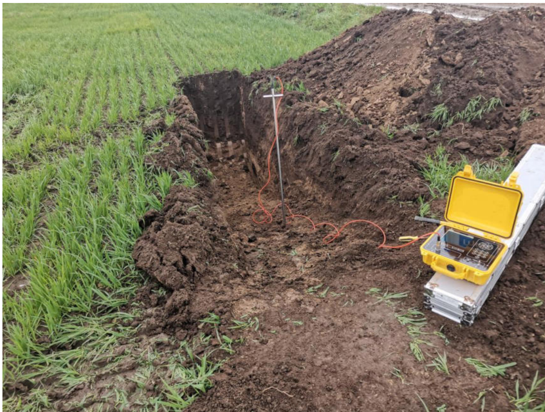
FOTO 1 – MISURE DI RESISTIVITÀ TERMICA TRINCEA 1
