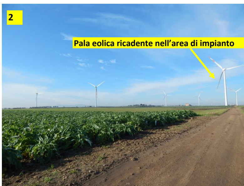
Foto dal cono visuale indicato nell'immagine precedente di Google Earth 7/7/19
