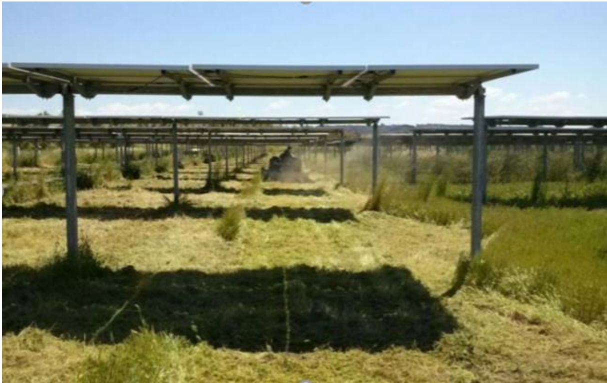
FIGURA 4 – FOTO DI ATTIVITA' MANUTENTIVE DEL VERDE SU IMPIANTI X-ELIO REALIZZATI IN ITALIA
