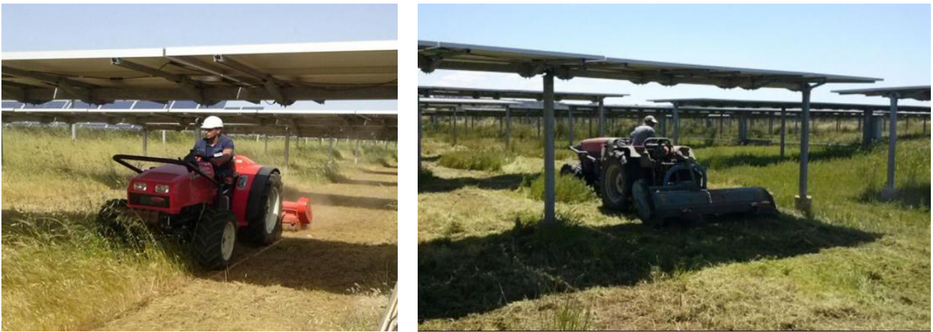
FIGURA 3 – ATTIVITA' AGRICOLE SU IMPIANTI REALIZZATI NEL 2011 (FOTO TRATTE DA UN REPORT DI MANUTENZIONE DEL 2014)
