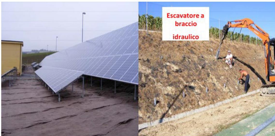
**Figura 59 - Esempio di posa delle strutture portanti**
