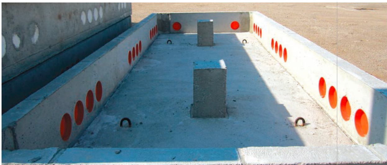
Figura 5 - Vasca di fondazione in CAV
