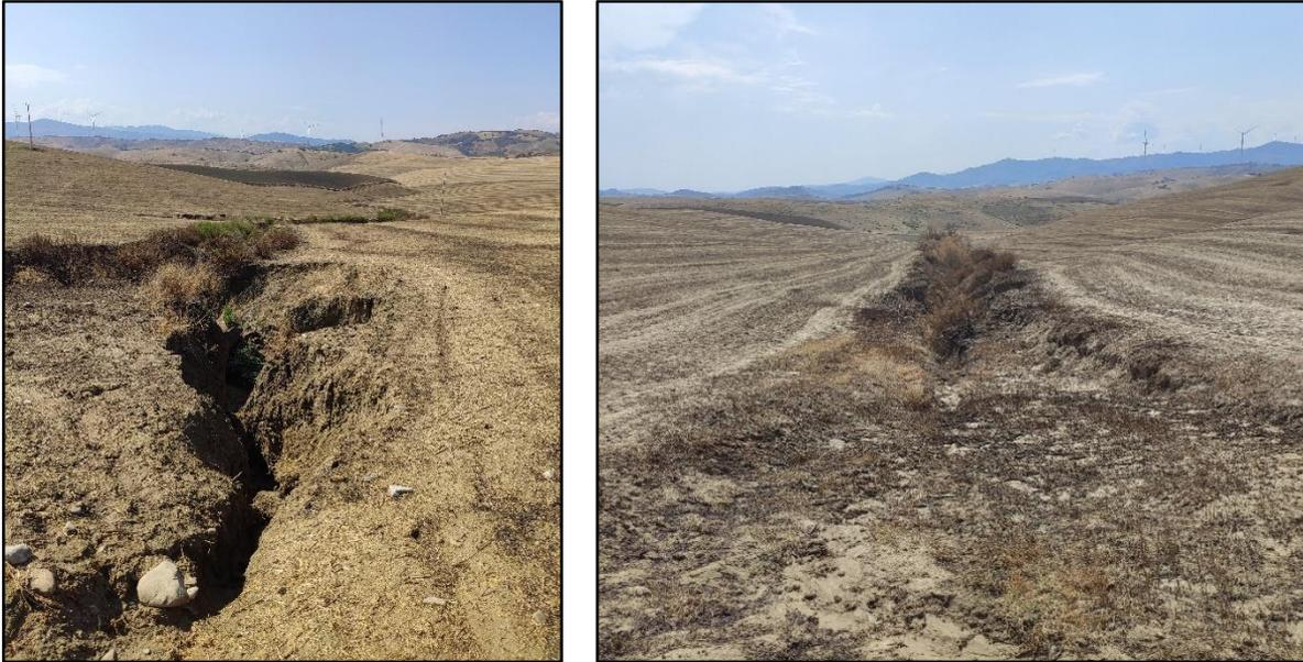
**Figura 7.** Dissesti lungo i due fossi principali. A sinistra il fosso nel settore Est dell'area impianto, a destra il fosso del settore ovest.
