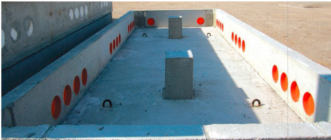
Figura 5 - Vasca di fondazione in CAV
