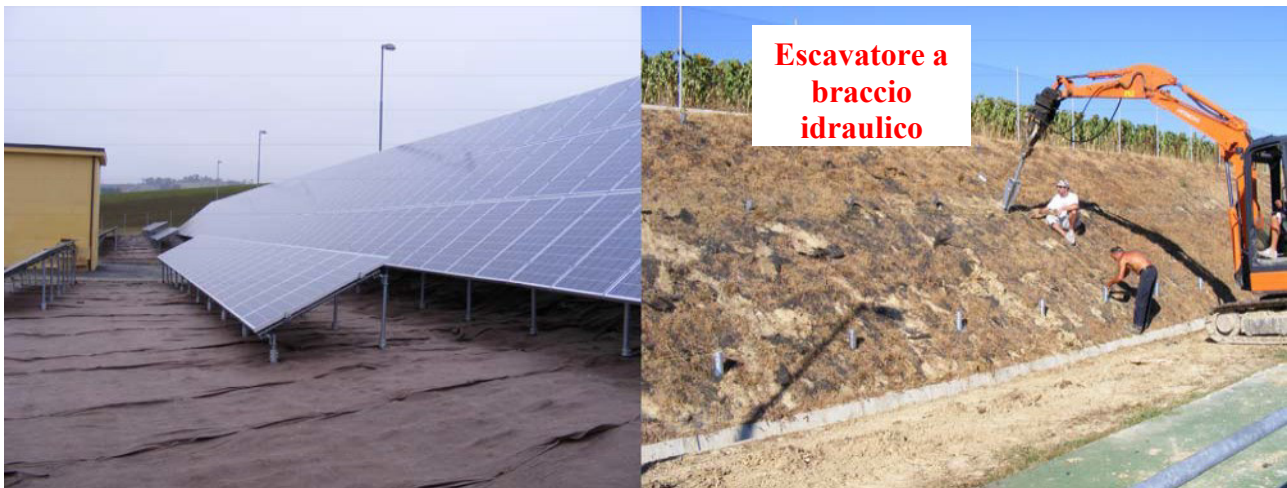
Figura 8 - Esempio di posa delle strutture portanti
