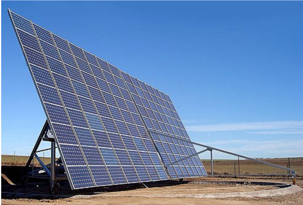
Figura 7 - Inseguitore biassiale "tilt – rollio"
