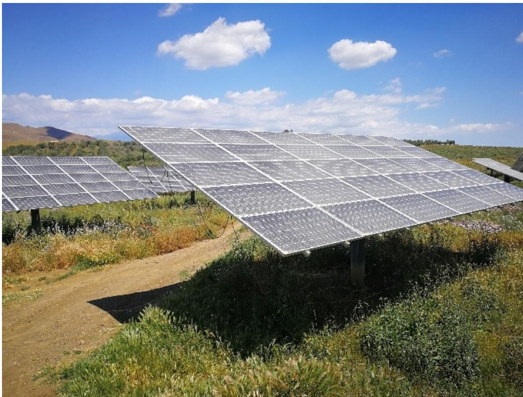
Figura 6 - Inseguitore biassiale "azimut-elevazione"
