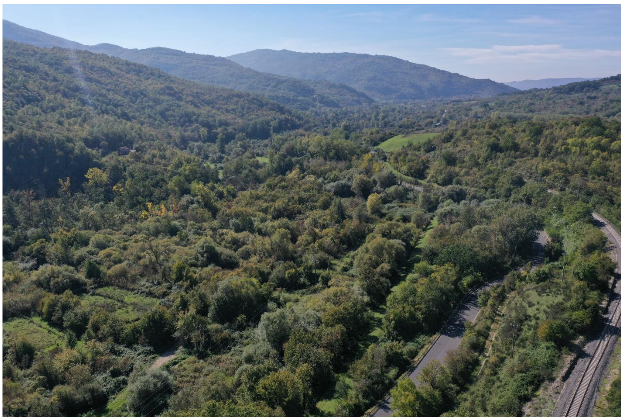
Figura 4-21: Foto aerea dell'area di cantiere TR4-PZ7
