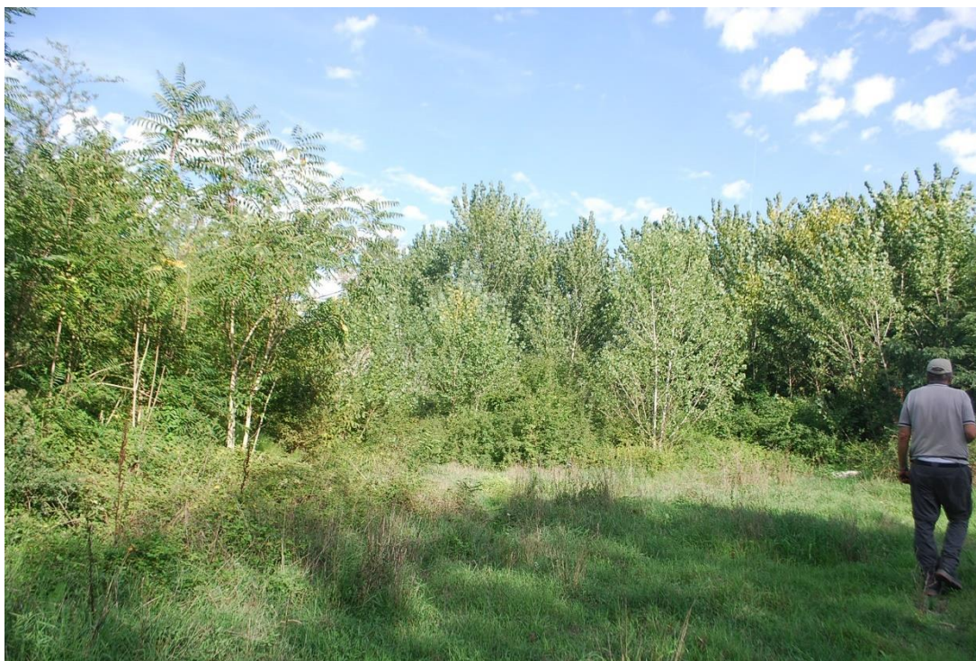
Figura 4-11: Area di cantiere TR4-Pz2
