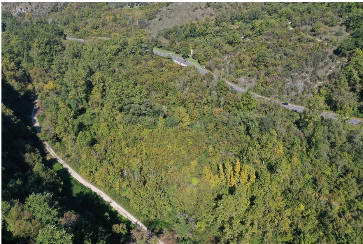
Figura 4-15: Foto aerea dell'area di cantiere TR4-Pz4
