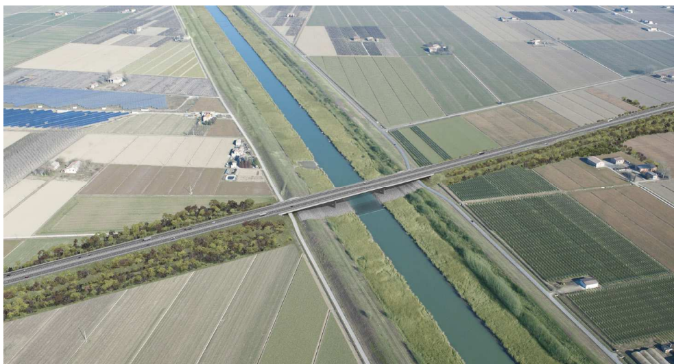
FIGURA 5.2-1 – PONTE SULLO SCOLMATORE DI RENO (CAVO NAPOLEONICO) PREVISTO DAL PROGETTO
