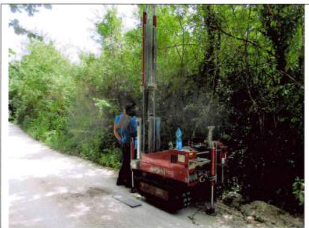
Esecuzione prova DPSH2 TR4-PZ3
