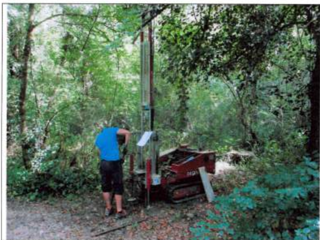
Esecuzione prova DPSH1 TR4-PZ1
