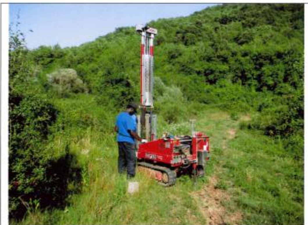
Esecuzione prova DPSH2 TR4-PZ8
