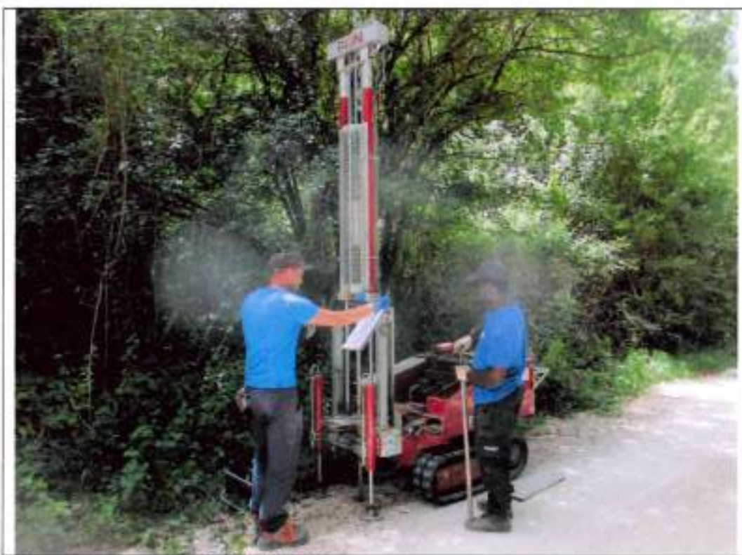
Esecuzione prova DPSH1 TR4-PZ3
