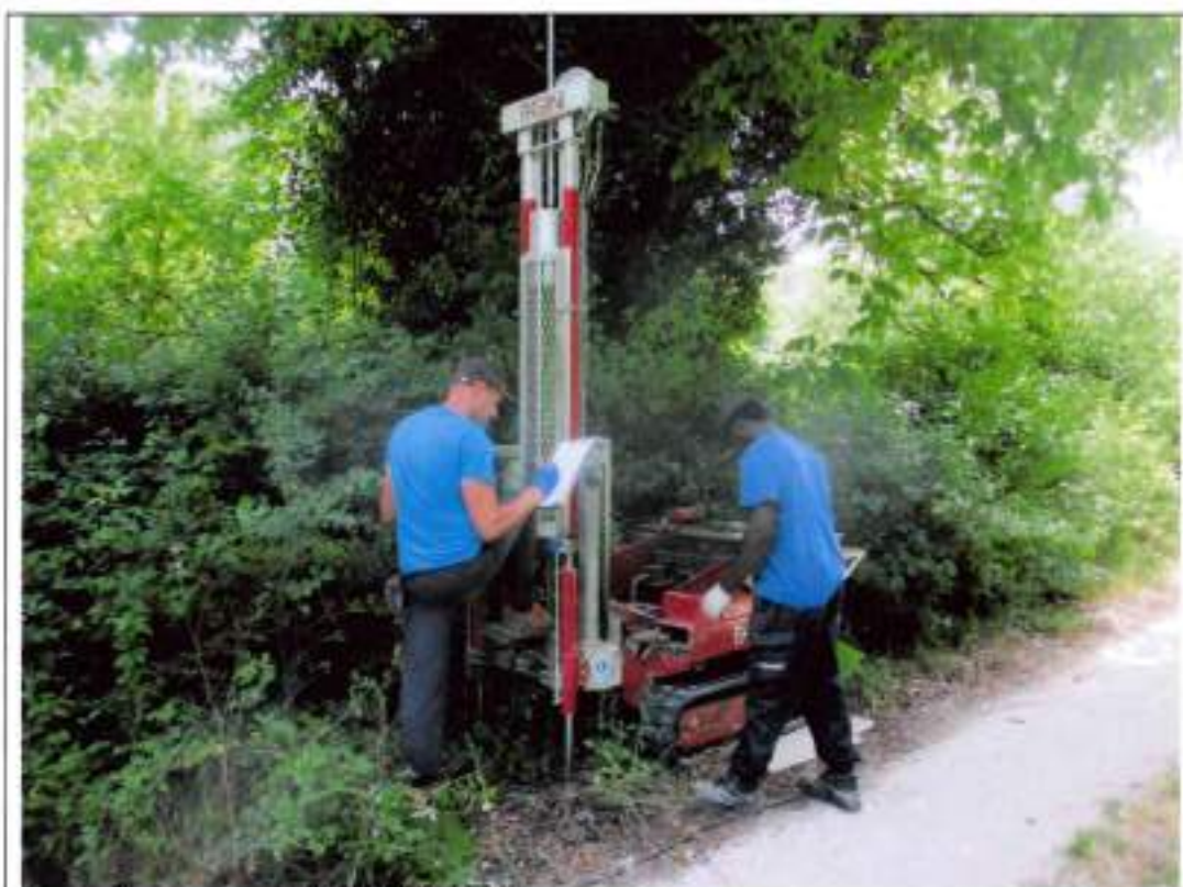
Esecuzione prova DPSH1 TR4-PZ4
