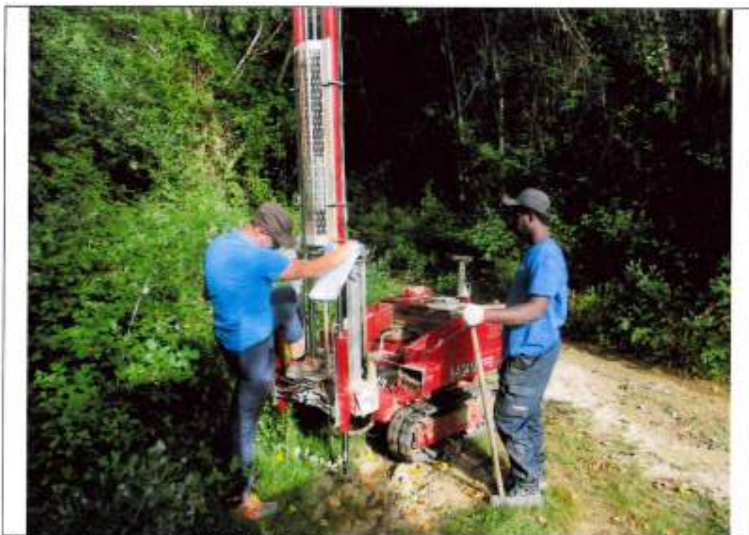
Esecuzione prova DPSHI TR4-PZ6
