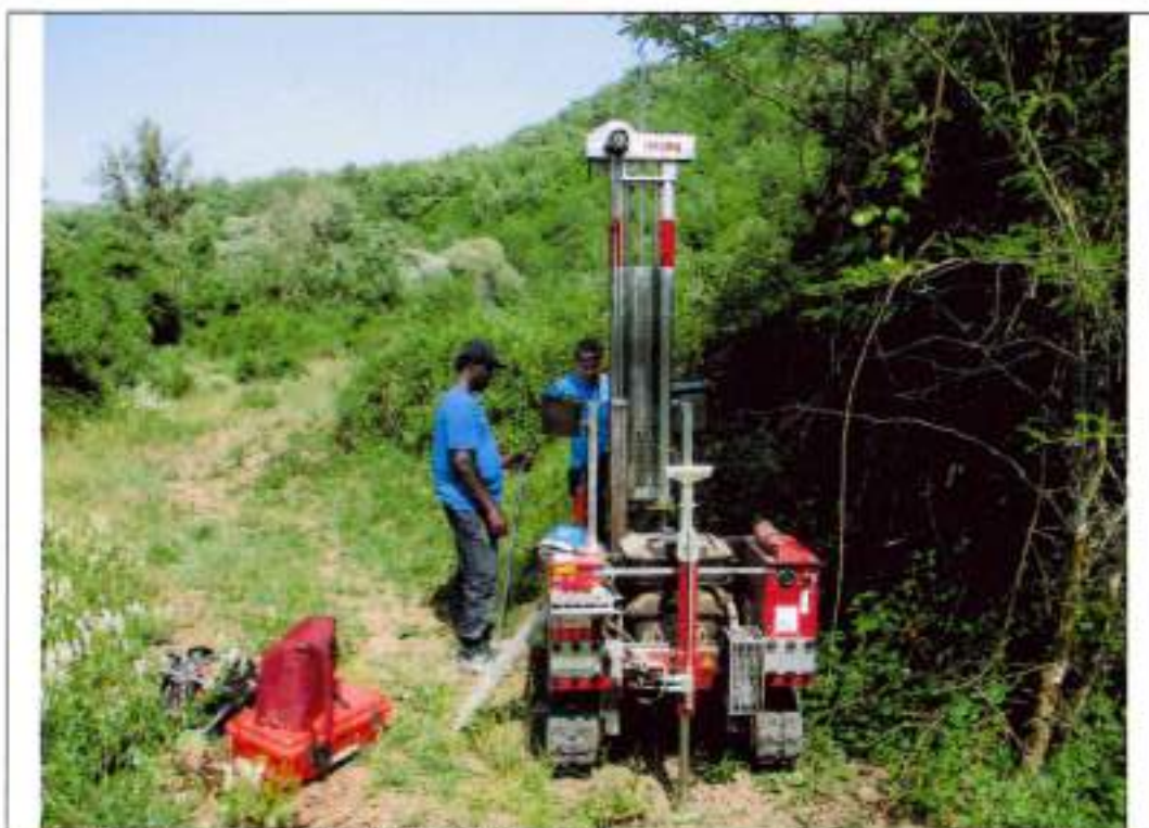
Esecuzione prova DPSH1 TR4-PZ8
