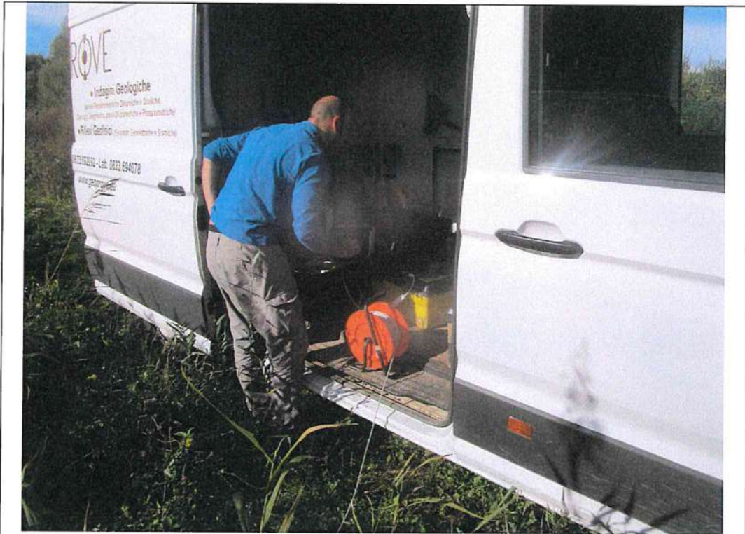
Esecuzione indagine sismica 4-4'
