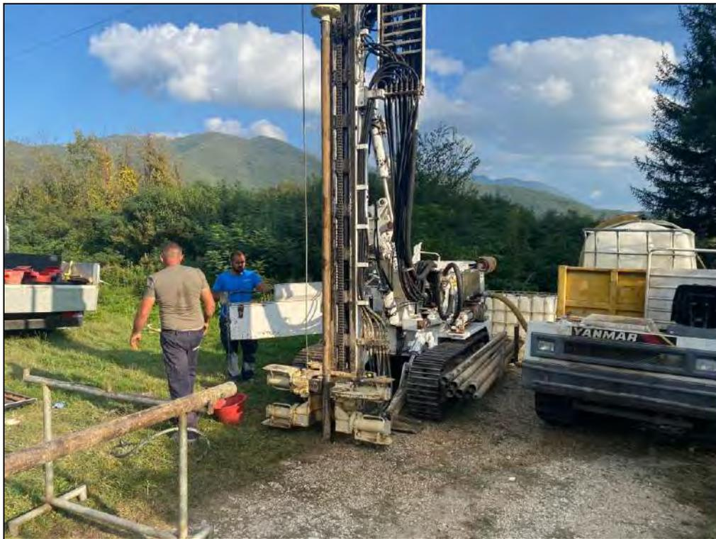
*Esecuzione sondaggio geonostico a carotaggio continuo S2*
