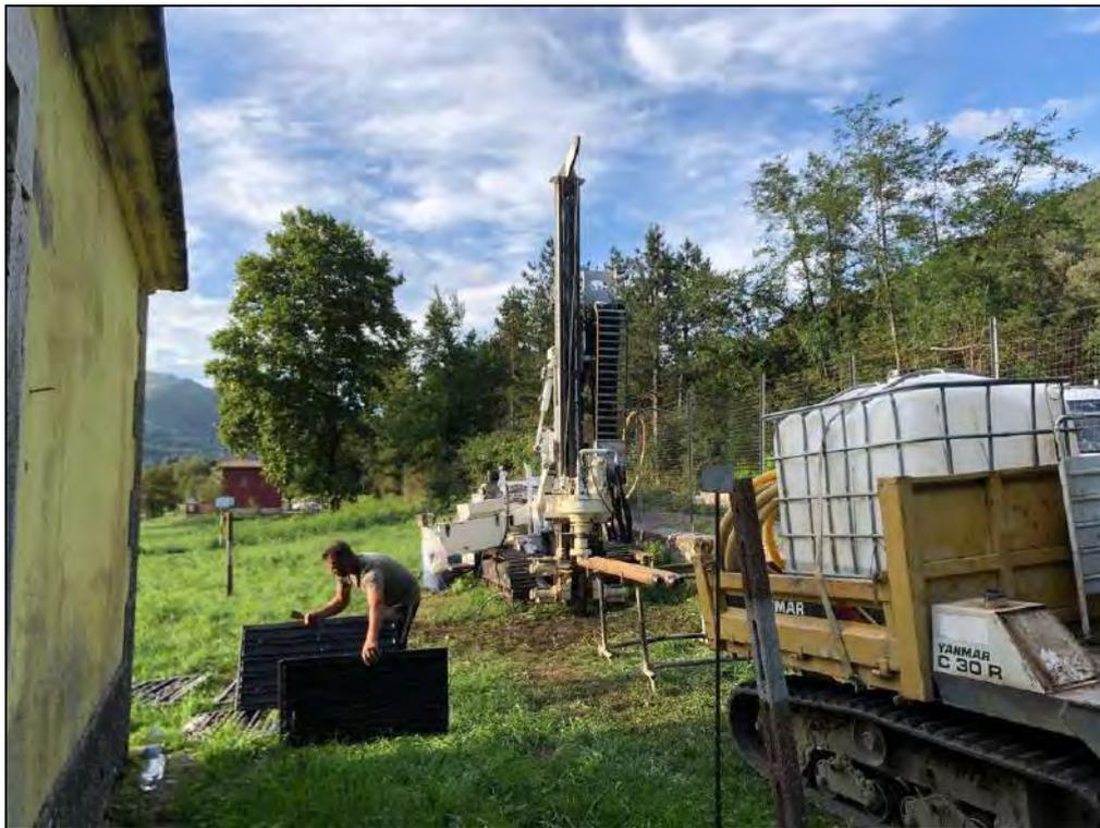
*Esecuzione sondaggio geonostico a carotaggio continuo S1*
