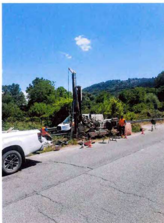
Esecuzione sondaggio geognostico a carotaggio continuo S10 bis (Pz)
