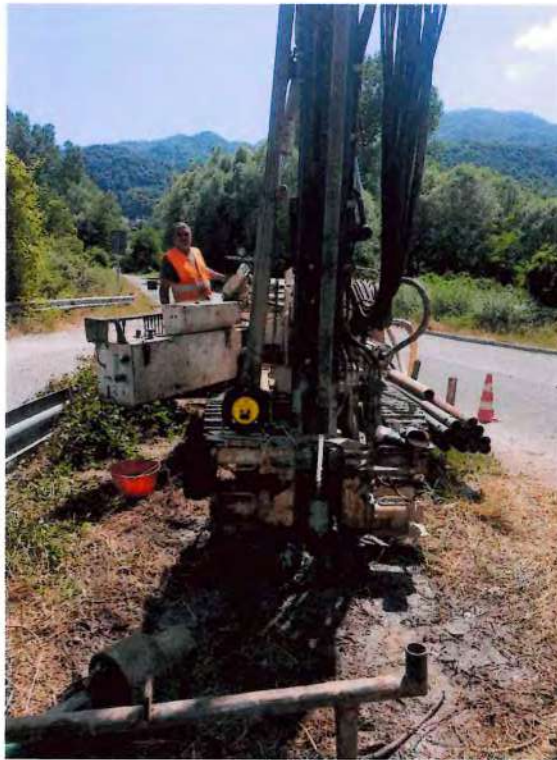
Esecuzione prove di permeabilità
