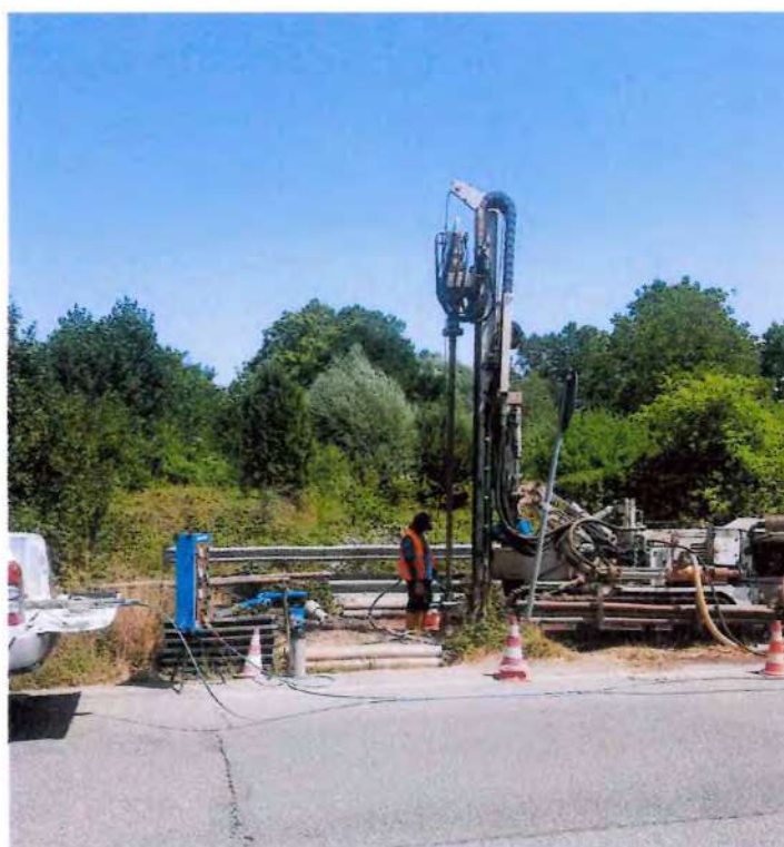
Esecuzione sondaggio geognostico a carotaggio continuo S10 tris (Pz)
