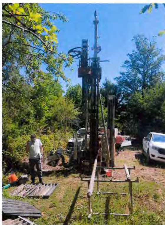
Esecuzione sondaggio geognostico a carotaggio continuo S16
