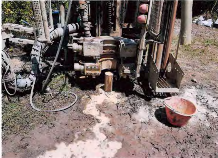
Esecuzione prove di permeabilità
