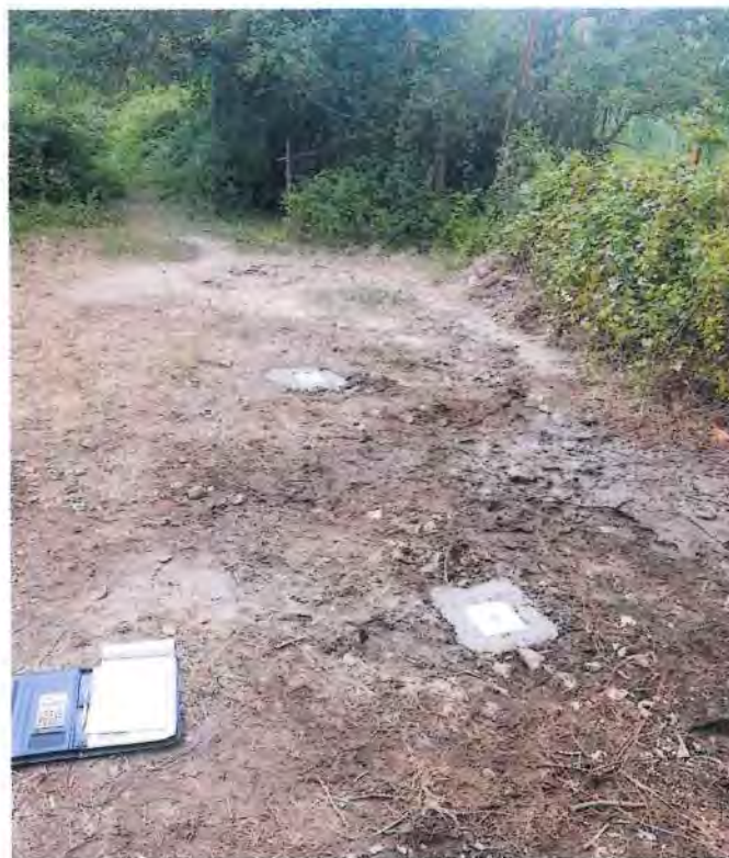
Esecuzione sondaggio geognostico a carotaggio continuo S16 bis (PZ)
