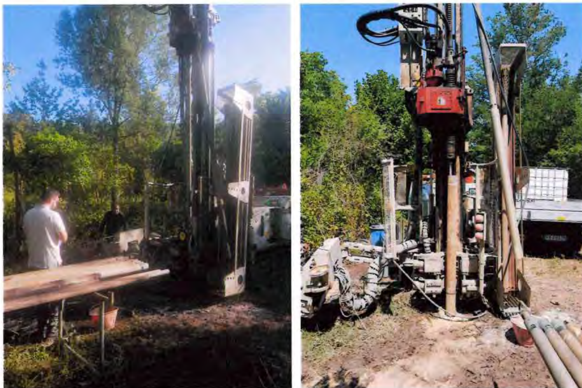
Esecuzione prove di permeabilità
