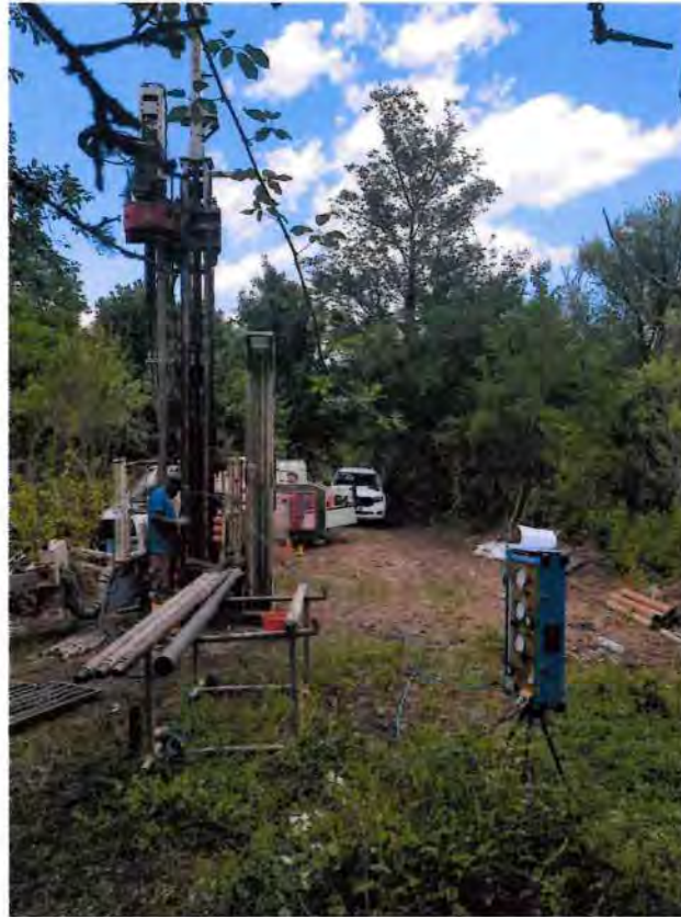
Esecuzione prove pressiometriche
