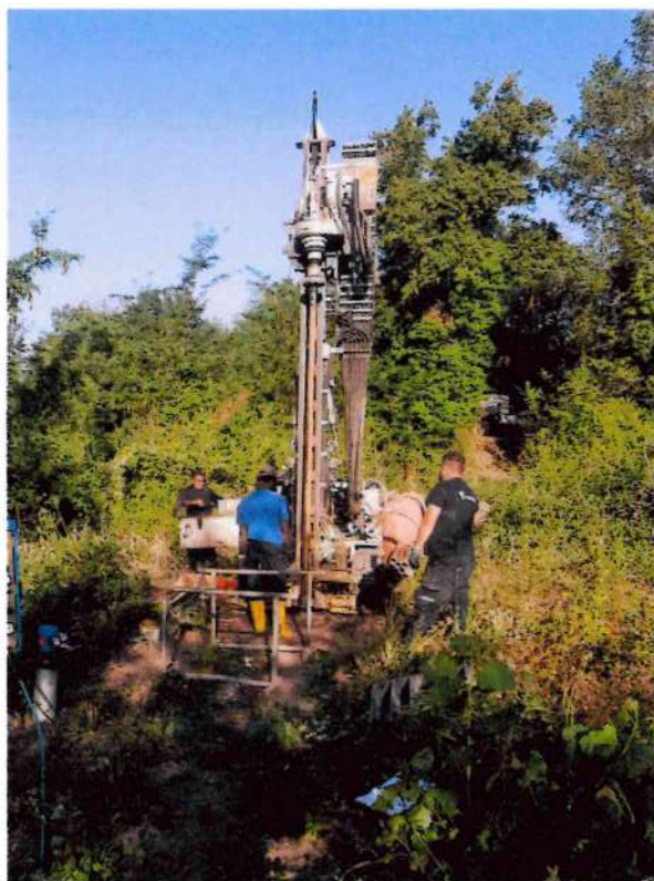
Esecuzione sondaggio geognostico a carotaggio continuo S17 (Pz)
