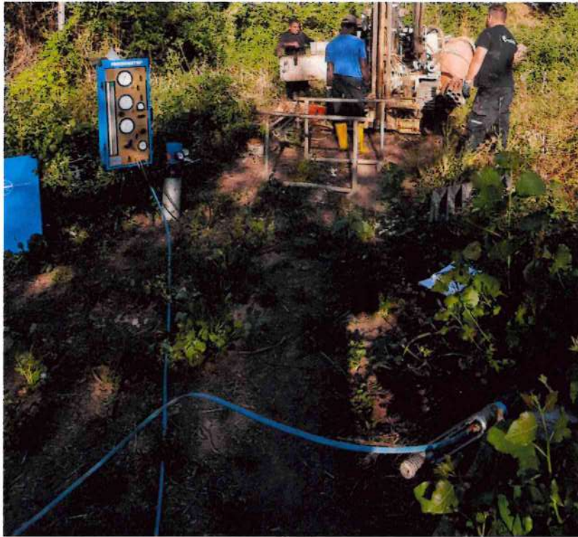
Esecuzione prove pressiometriche
