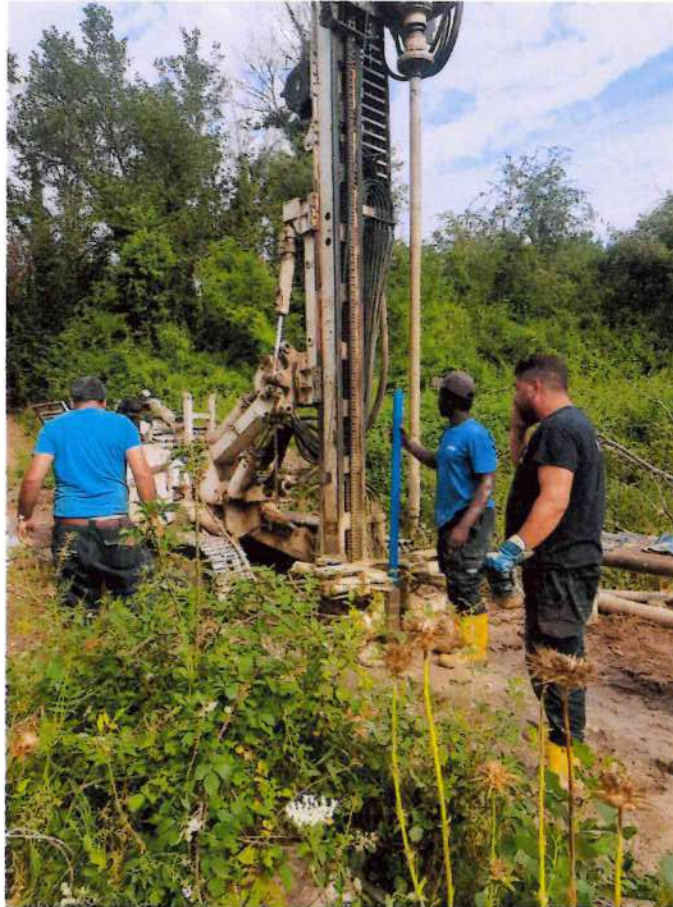
Allestimento del sondaggio S17 a Piezometro
