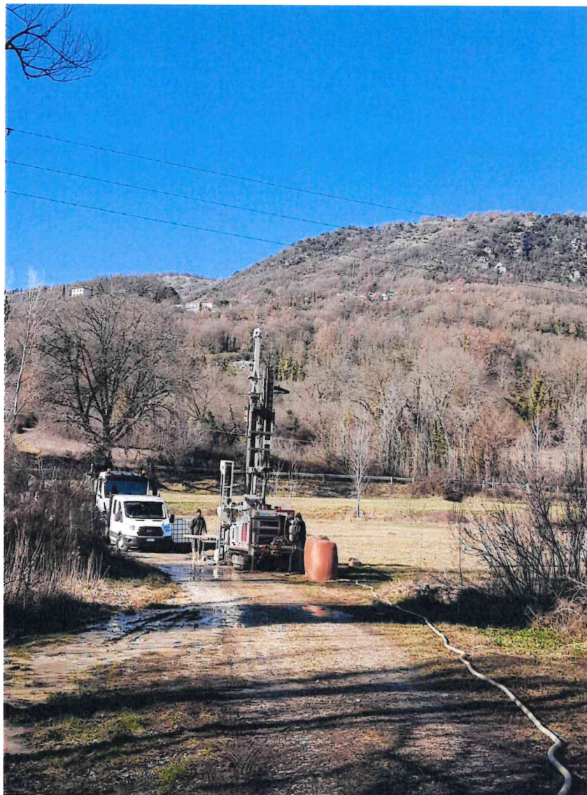
Esecuzione sondaggio S2bis
