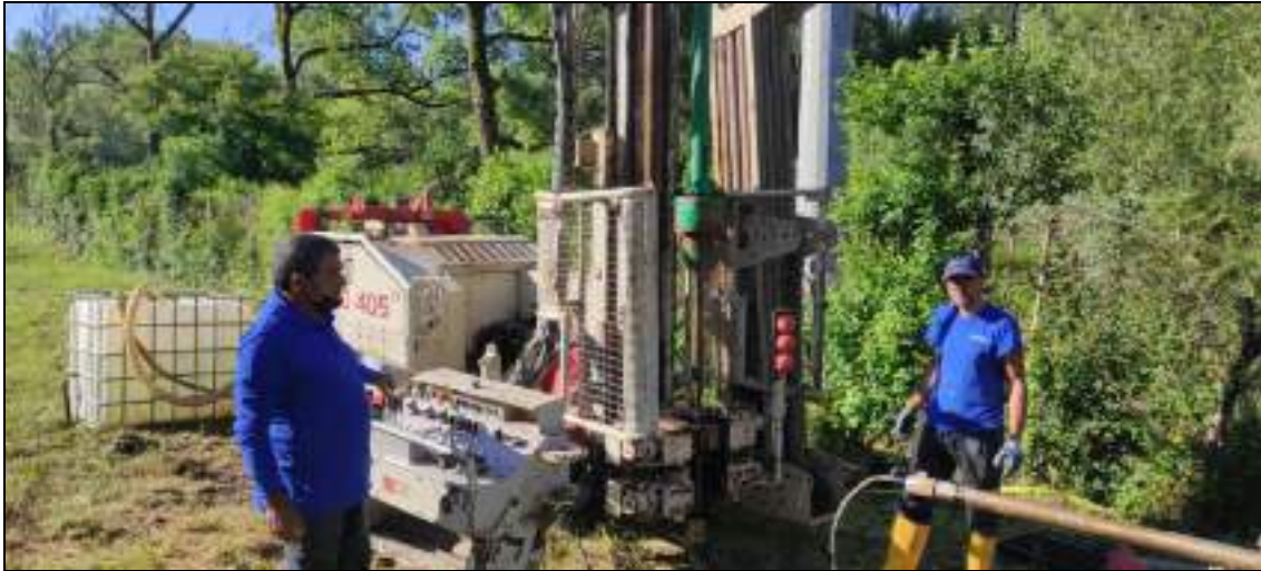
Esecuzione prova SPT
