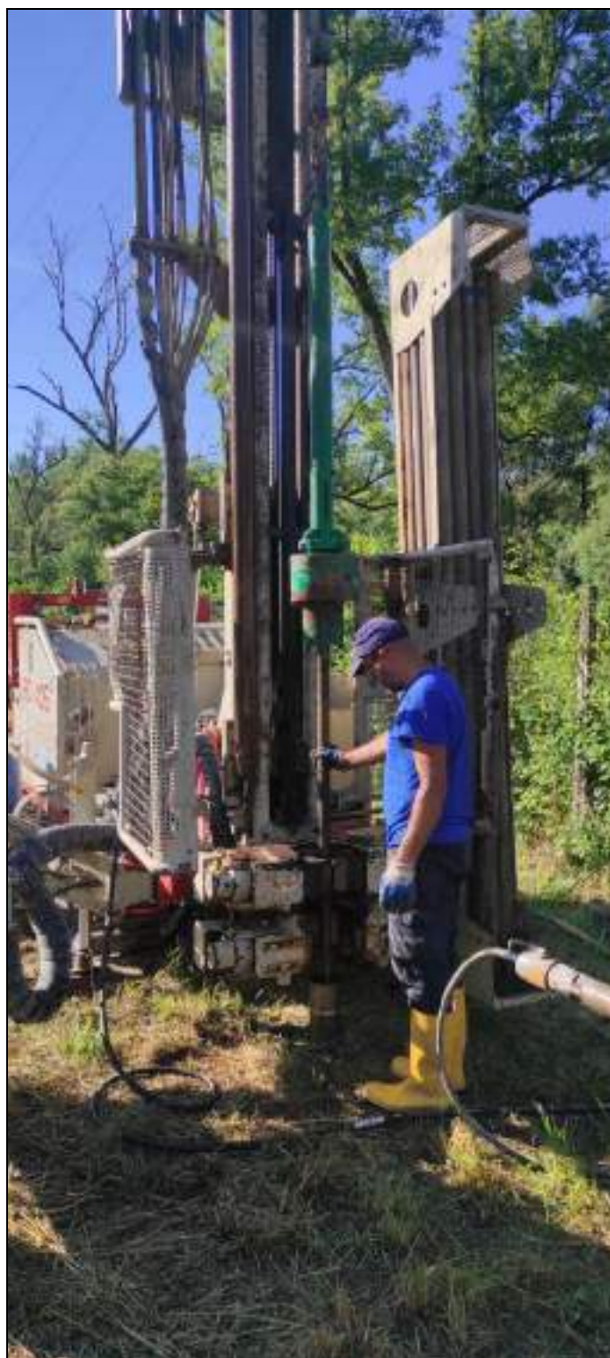
Esecuzione sondaggio geognostico a carotaggio continuo S3bis
