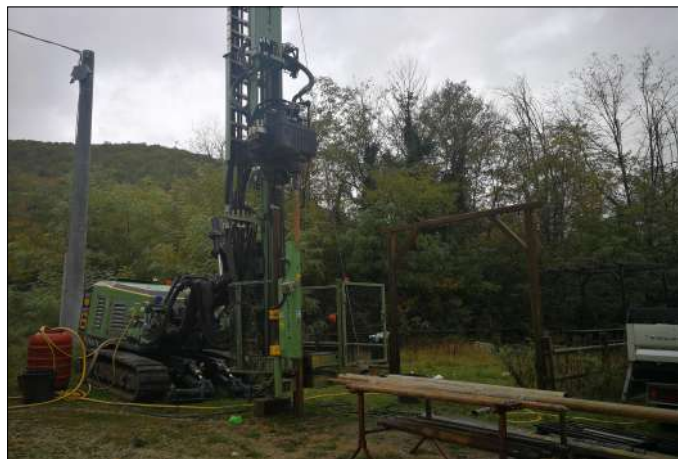
Postazione del sondaggio S4
