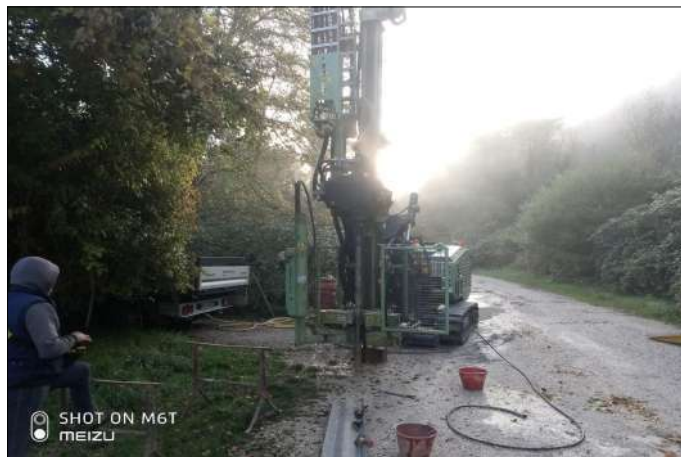
Postazione del sondaggio S6
