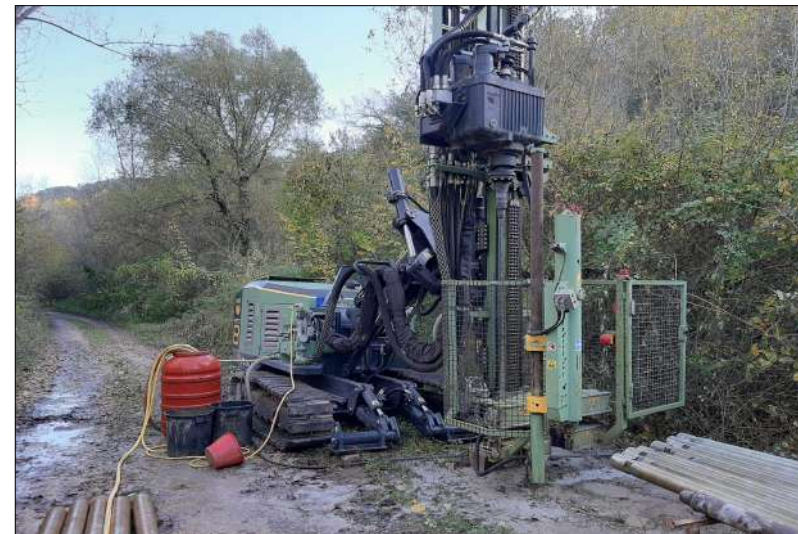
Postazione del sondaggio S12
