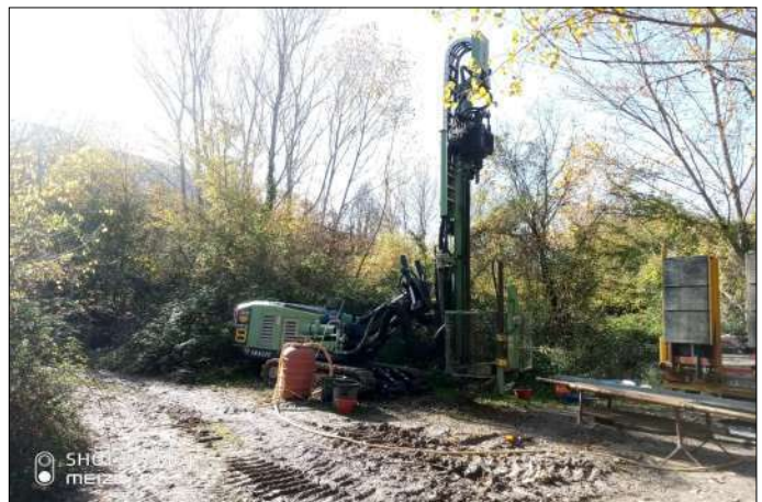
Postazione del sondaggio S13
