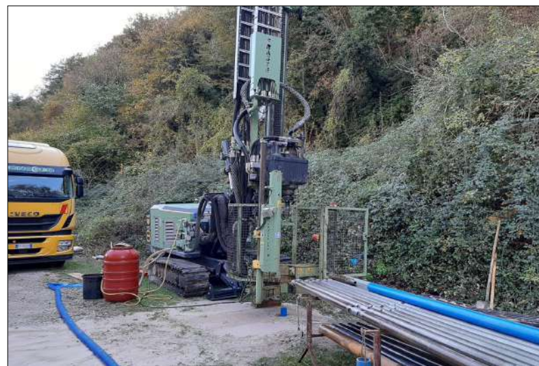
Postazione del sondaggio S8
