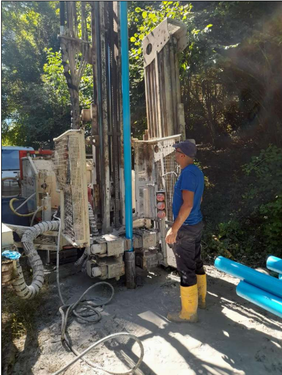
Istallazione tubo piezometrico
