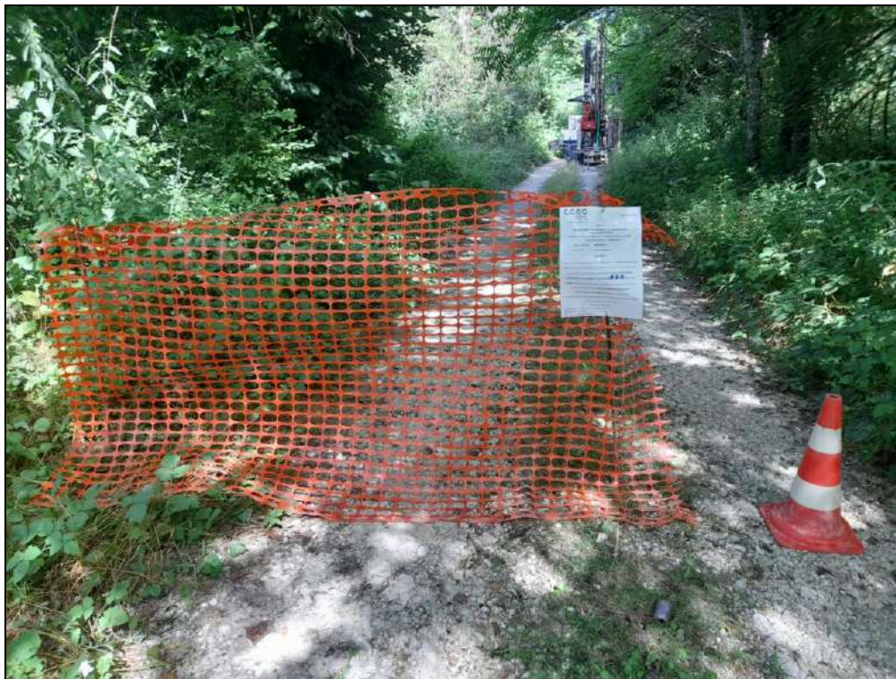
Esecuzione sondaggio geognostico a carotaggio continuo S9
