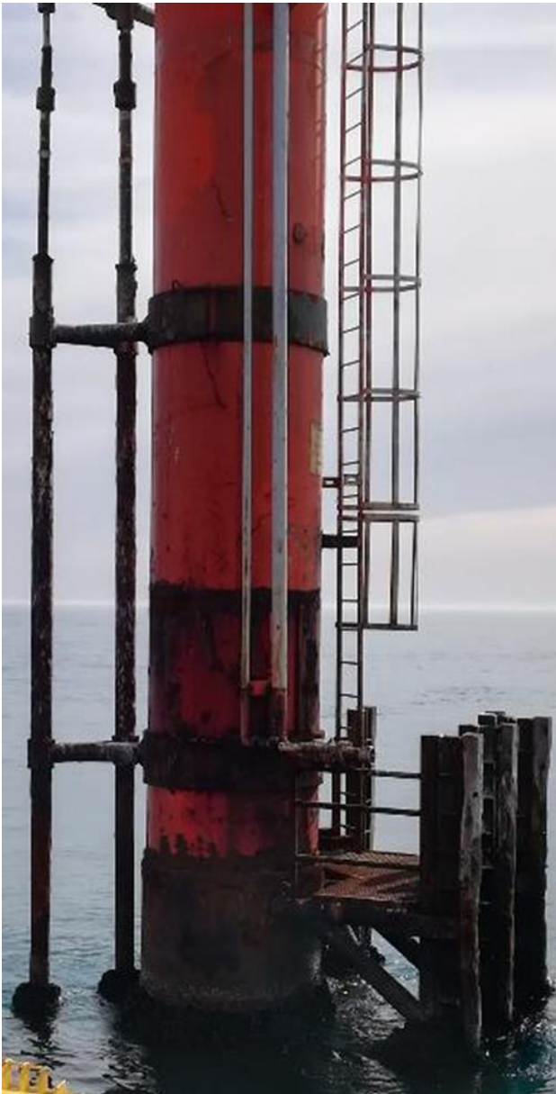
Figura 2.4– Regina 1 – Monotubolare e risalite di condotte sottomarine (3" e 4" gas), viste generali
