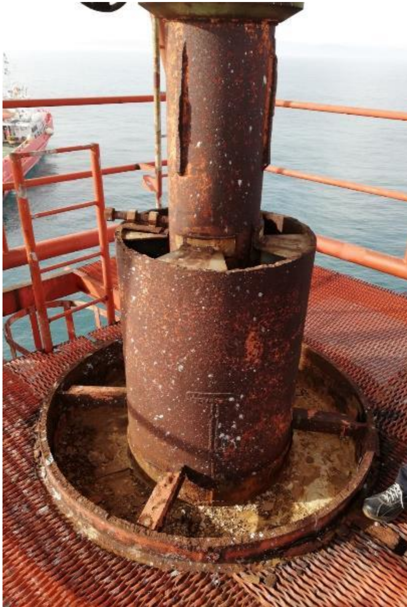
Figura 2.2 – Regina 1 – Particolare cementazione tubo esterno – tubo guida
