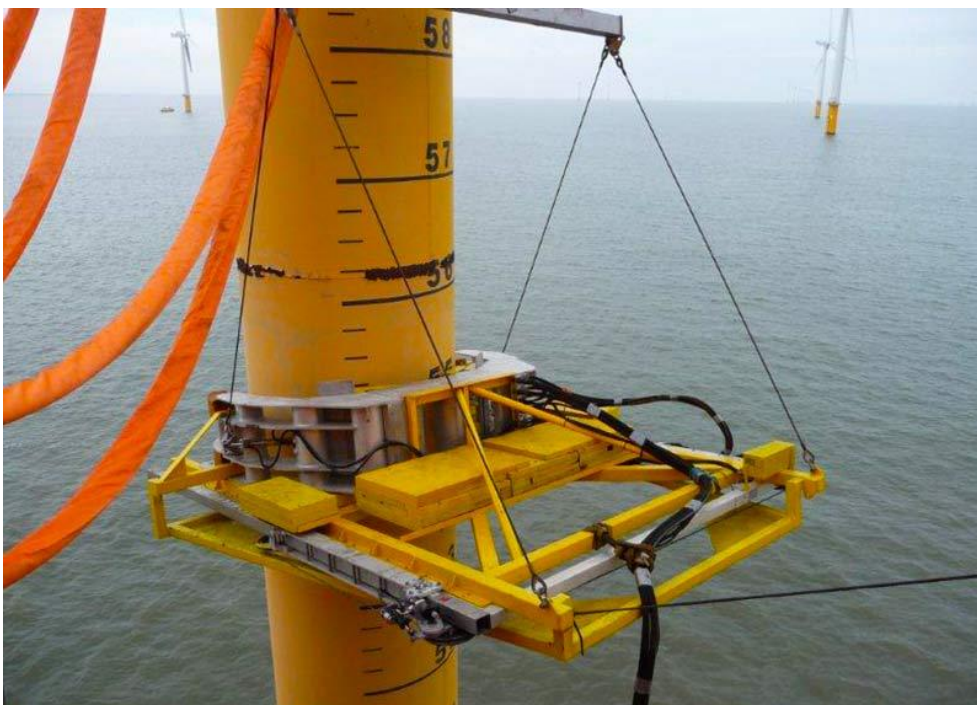
Figura 3.7 – Sistema di taglio DWCS per taglio a cavo diamantato – Tipico
