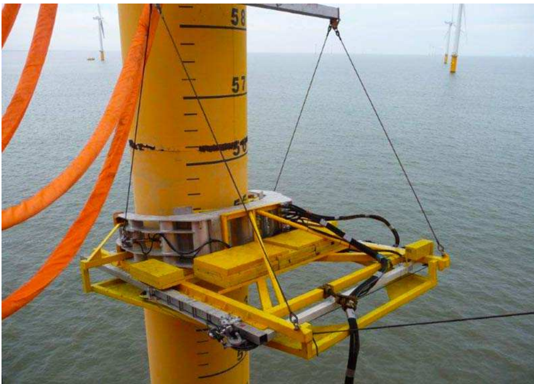
Figura 10-14 – Sistema di taglio DWCS per taglio a cavo diamantato - Tipico
