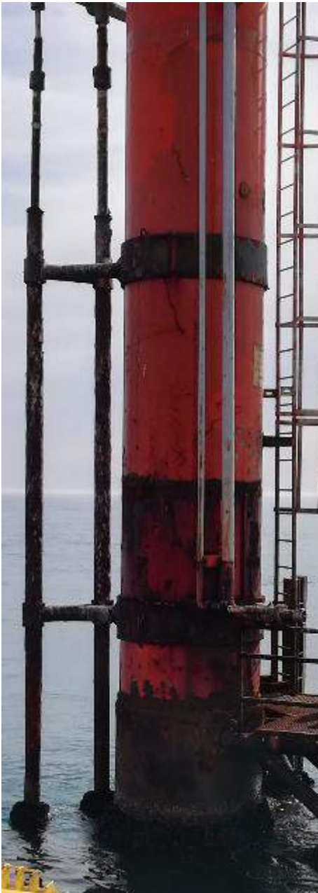
Figura 3-1 – Regina 1 – Monotubolare e risalite di condotte sottomarine (3” e 4” gas), viste generali.
