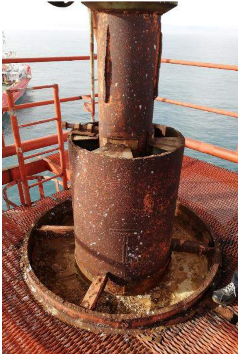
Figura 3-2 – Regina 1 – Particolare cementazione tubo esterno – tubo guida.
