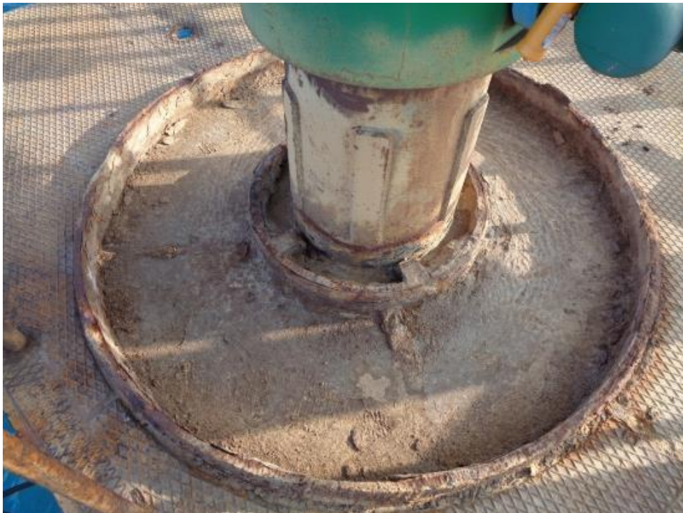
Figura 2.2– Armida 1 – Particolare cementazione all'interno della monotubolare
