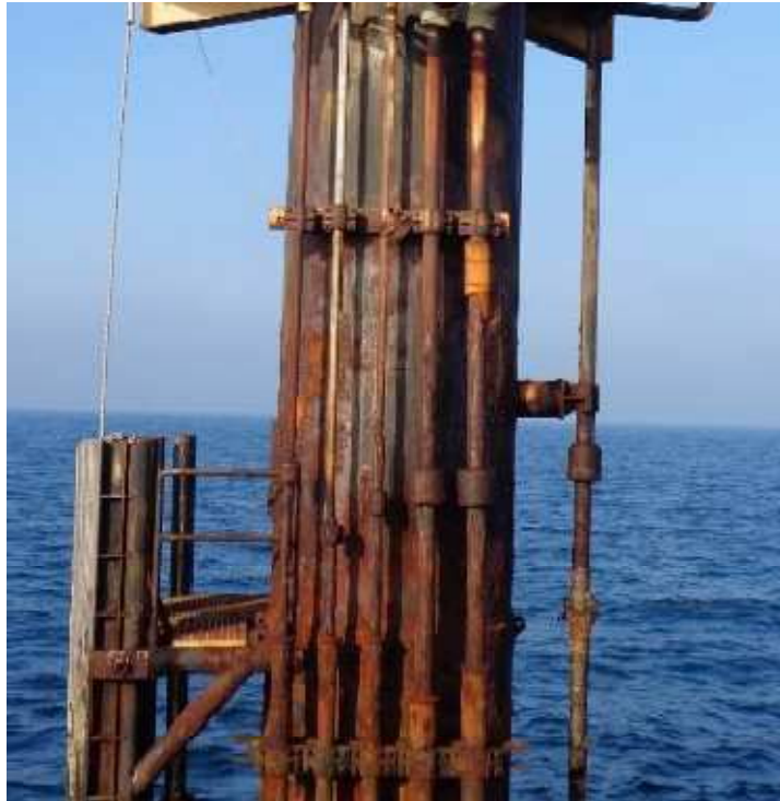
Figura 3-3 – Armida 1 – Risalite di condotte sottomarine, vista generale
